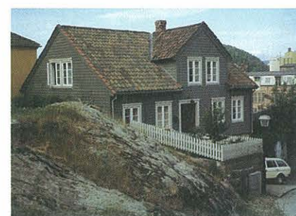
Peder Colbjørnsens gate 4 fotografert etter ombygging. Husets opprinnelige form og fasader er rekonstruert. Arkitekt: SG arkitekter.
