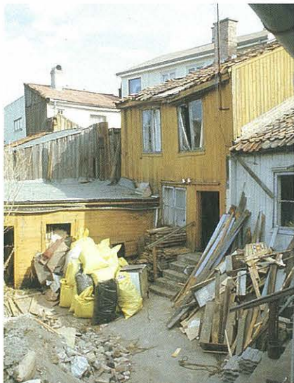
Peder Colbjørnsens gate 1. Bakgården fotografert før ombygging i 1981. Sidefløy og uthus var fra forskjellige epoker og teknisk sett i meget slett tilstand. Bakgårdsbebyggelsen ble revet.
