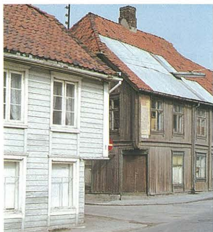
Et velkjent motiv i gamle Halden i krysset Øvre Bankegate / Oscarsgate. "Gløersegården" til venstre og "Konservativen" til høyre. Fotografiet er tatt før bygningene ble reddet i 1981.
