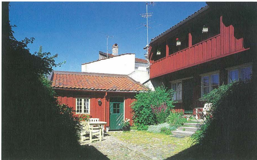
Samme bakgård etter ombygging. Sidefløy har fått en fri form. Uthus ble satt opp av gjenbruksmaterialer. Hovedfløy fikk tilbakeført fasadene. Arkitekt: SG arkitekter. Foto: Terje Solvang
