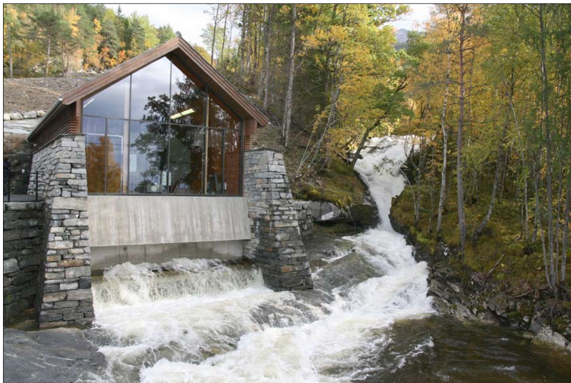
Kraftverk på Ytre Alsåker, Ullensvang.
