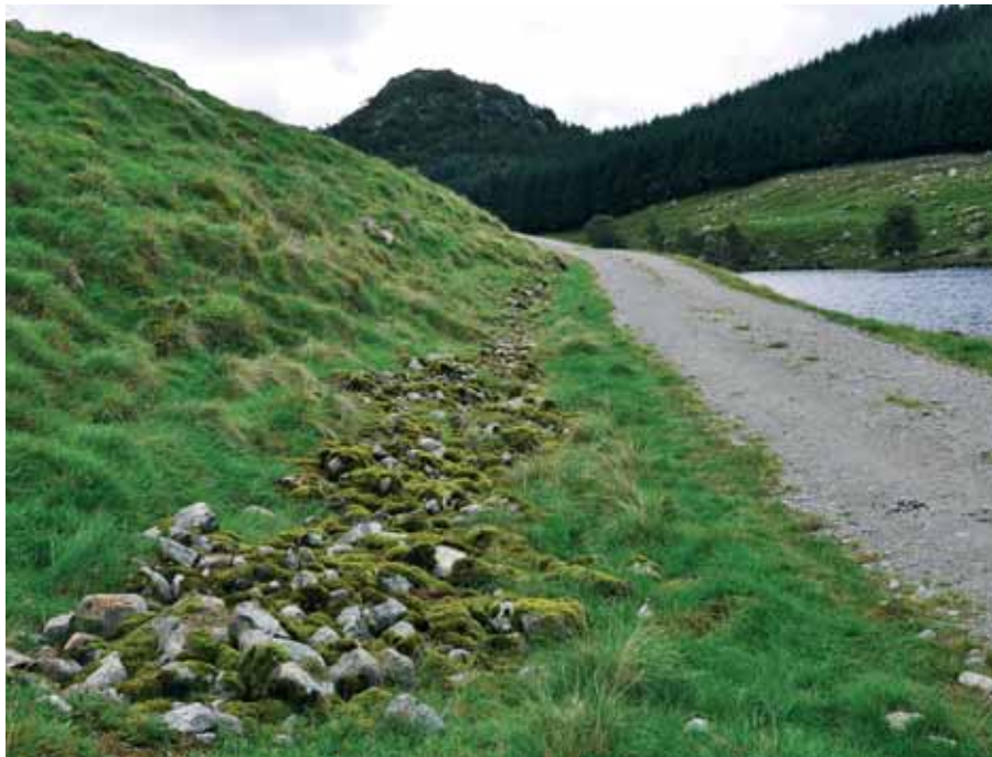
Steinsett grøft med steinfylling oppå, tar unna mykje vatn.
