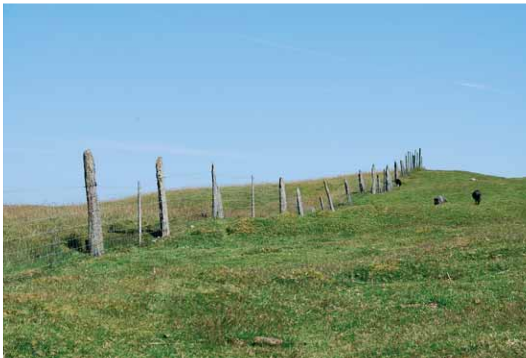
Ein betydeleg del av gjerdet rundt Røsslyngen beitelag sitt område på 1 300 dekar er piggsteingjerde. Ved restaurering av gjerda var det ein føresetnad at piggsteinen skulle nyttast.
