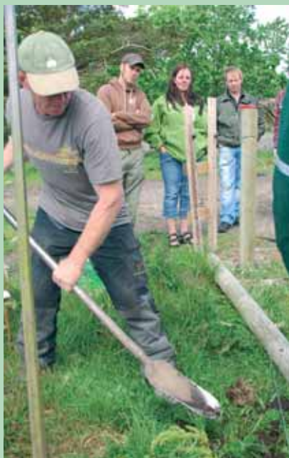
Stephen Good demonstrerer spesialspade til graving av stolpehol.
