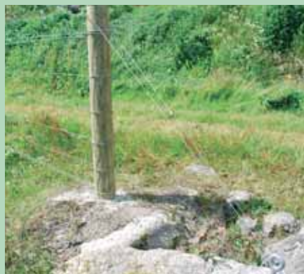
Endestolpe i fjell. Her er det bora ned ei stålstong. Trestolpen er saga av, det er bora hol som passar til stålstanga i steinen og stolpen er tredd over. Stolpen er bardunert.
