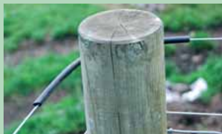
Isolasjon på straumtråden på ein hjørnestolpe.
