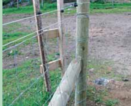
Endestolpe i lausmasse. Her er det 12 cm stolpe, bardunert og med skråstilt støttestolpe. Legg merke til vernetrådar oppe og nede, og straumtråd oppe. Det er ikkje brukt krampar, men enden av nettet er skøytt saman slik at draget kjem midt på stolpen.
