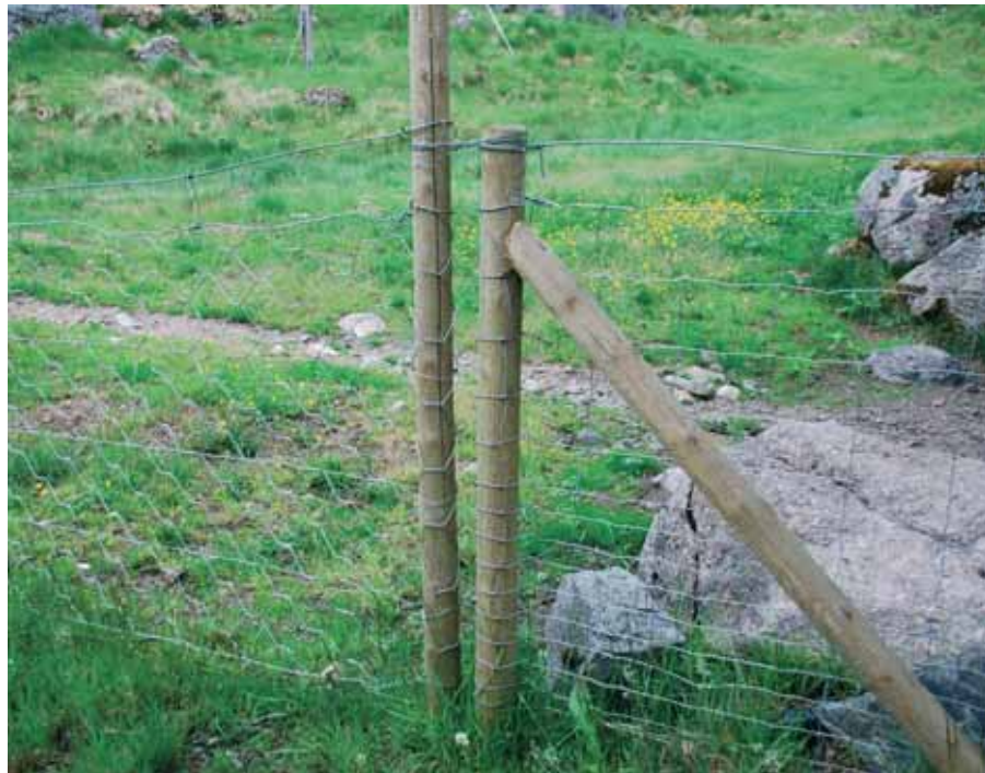
Tre nettingtypar blir testa ut på yttergjerdet, her sekskantnetting til venstre og lammenetting til høgre. Pålane er for det meste sette opp med 1,5 m avstand. Gjerdekostnaden, inklusive eigeninnsats, er rekna til 90 – 100 kroner pr. løpemetar.
