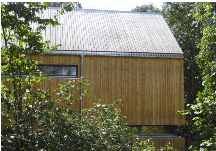
Villa Stoknes, nytt passivhus i Oslo. Foto: SINTEF Byggforsk
