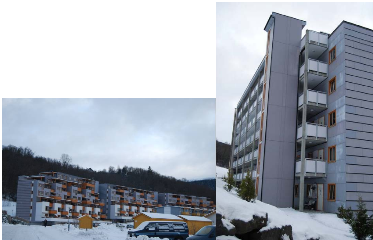
Figur 3 Boligblokk i 7 etasjer over kjellergarasje i kommune med brannvesen uten stige- eller liftbil. Brannvesenet har ikke mulighet til å komme frem med bil på den ene langsiden av boligkomplekset som ligger i bunnen av en skråning.
