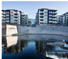
Det tidligere industriområde i Nydalen har nå blitt et attraktivt byrområde i Oslo med boliger og næring side om side. I dag kommer Nydalen flere arbeidsplasser enn fra som var tilfelle med det gamle spilleverket. FOTO: TOM A. KOLSTAD
