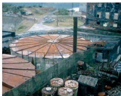
Lagringstanker for brukt kjernebrensel i Andrejevbukta. Foto: SevRao.
