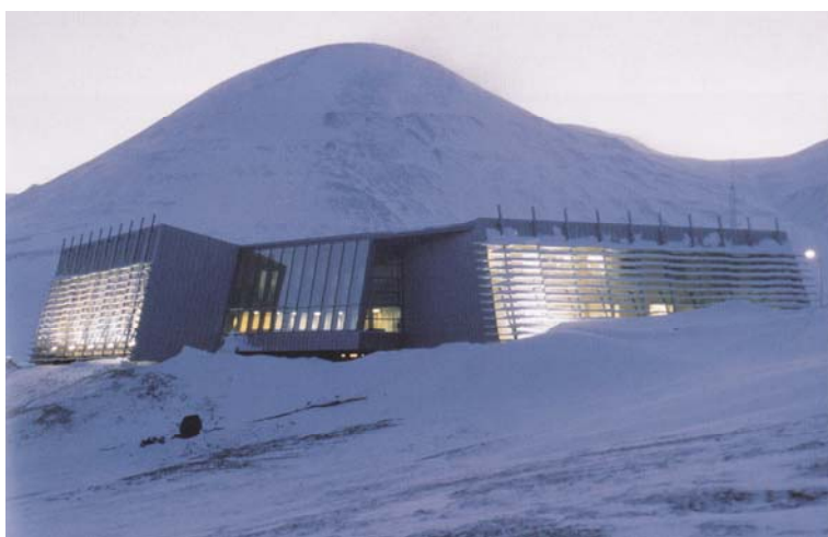
SYSSELMANNENS ADMINISTRASJONSBYGG fra 1995.
