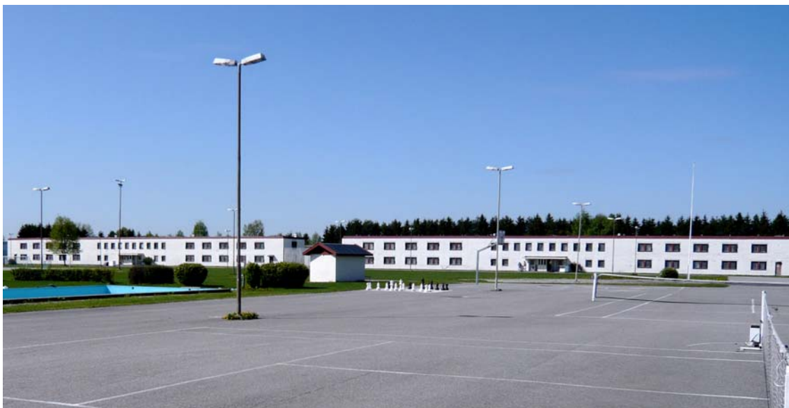
FORLEGNINGENE PÅ ULLERSMO bygget i 1971.
