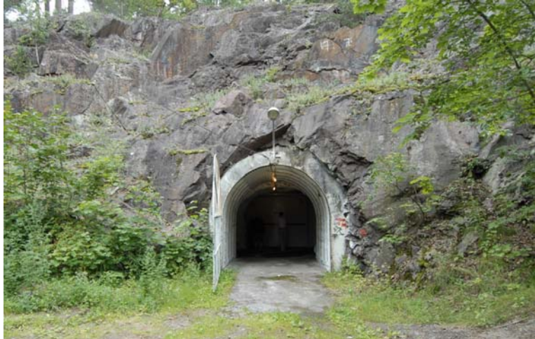
INNGANG TIL ALARMPASS.
