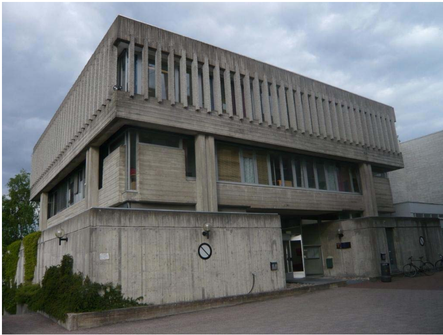
SANDVIKA TINGHUS. Sandvika tinghus og politihus ble oppført med prefabrickerte betongelementer i 1971. Anlegget var del av statens store byggevirkksomhet på 1960- og 70-tallet. I de første byggeplanene var posten og arbeidskontoret med i prosjektet og navnet var Statens hus i Sandvika. Det endelige byggeprosjektet omfattet lokaler for politi, lensmann og rettsvesen, samt vaktmesterbolig og et stort parkeringsanlegg. Kommunen satte som vilkår at tinghuset skule ha 110 parkeringsplasser. Prosjektet endret navn til Justisbygget i Sandvika.
