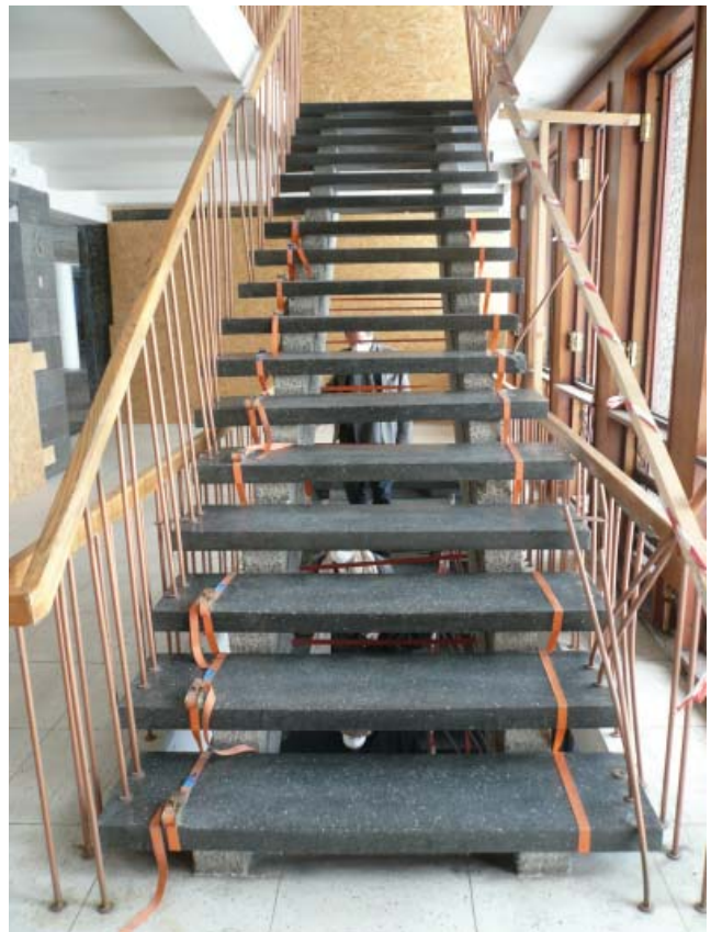
H-blokk | Hovedtrapp Foto: LPO | september 2012
