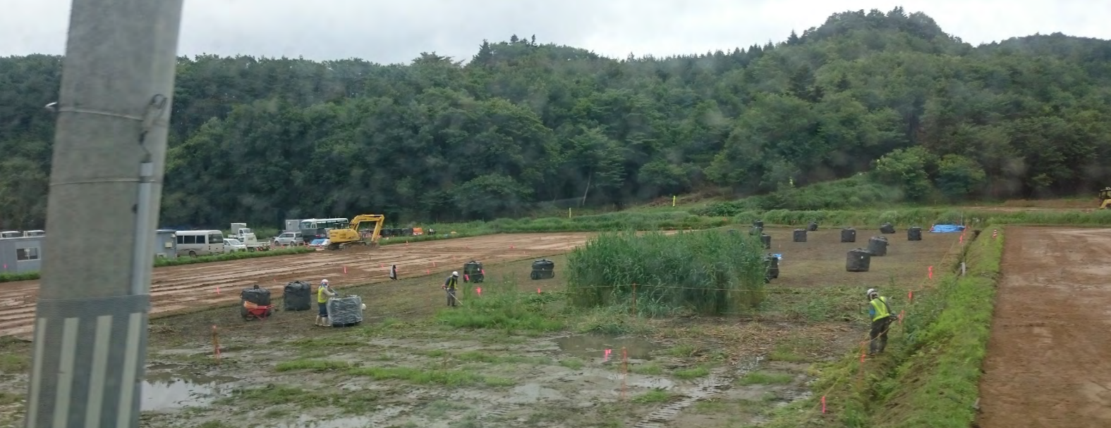
Reinsking av rismark i litate 5 år etter ulykka. Fyrst blir vegetasjonen fjerna, så blir dei øvste 5 cm av jorda skrapa av, og så blir det lagt på eit nytt lag med jord som ikkje er forureina. Alt avfall blir samla i dei svarte sekkane. Foto: Lavrans Skuterud, Strålevernet.
