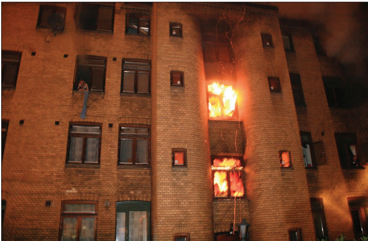
Figur 5.1 Brann i eldre murgard i Urtegata i Oslo i 2008.
