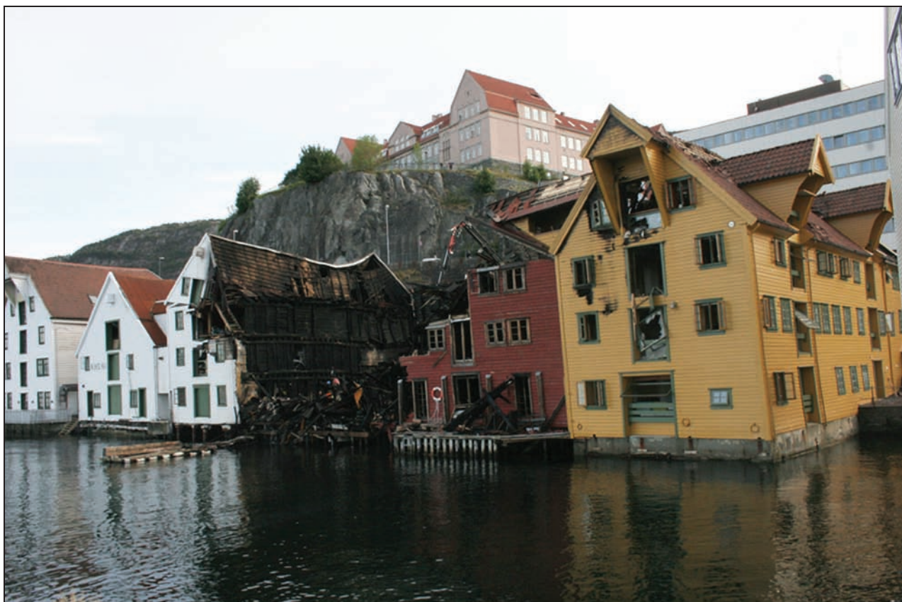
Figur 5.5 Brann i Skuteviksbodene i Bergen i 2008 førte til at fire vedtaksfredede bygninger gikk tapt.
