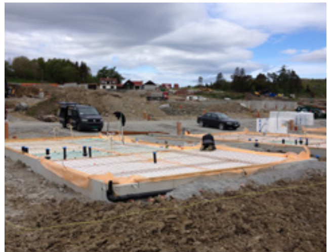
Byggeplass, boligprosjekt på Kleivane i Sandnes.
