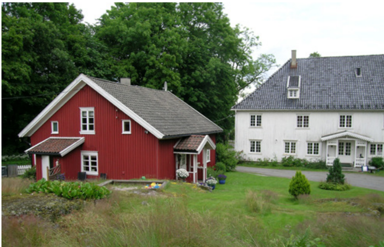
Tanum prestegård, Brunlanes i Larvik kommune like ved Tanum middelalderkirke. Prestegårdens hovedbygning ble oppført i perioden 1762-1767. Våningshuset er en stor to-etasjes laftet tømmerbygning med høyt valmtak. Forpakterboligen på en etasje er oppført i 1760-70 årene. Prestegården er kjent som hjem for forfatter og husmor Hanna Winsnes, som sammen med sin ektefelle, prest og stortingsmann Paul Winsnes hadde sin lengste virketid her i årene 1830-45. På prestegården holdt Hanna Winsnes bl.a. husstell-opplæring for unge piker.
