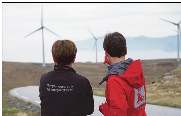
Figur 4.5 NVE på tilsyn i forbindelse med reetablering av Mehuken vindkraftverk.
