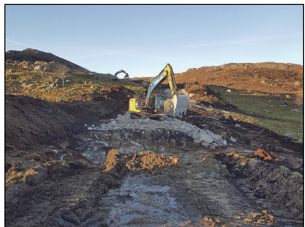
Figur 6.4 Bygging av Bjerkreim vindkraftverk.
