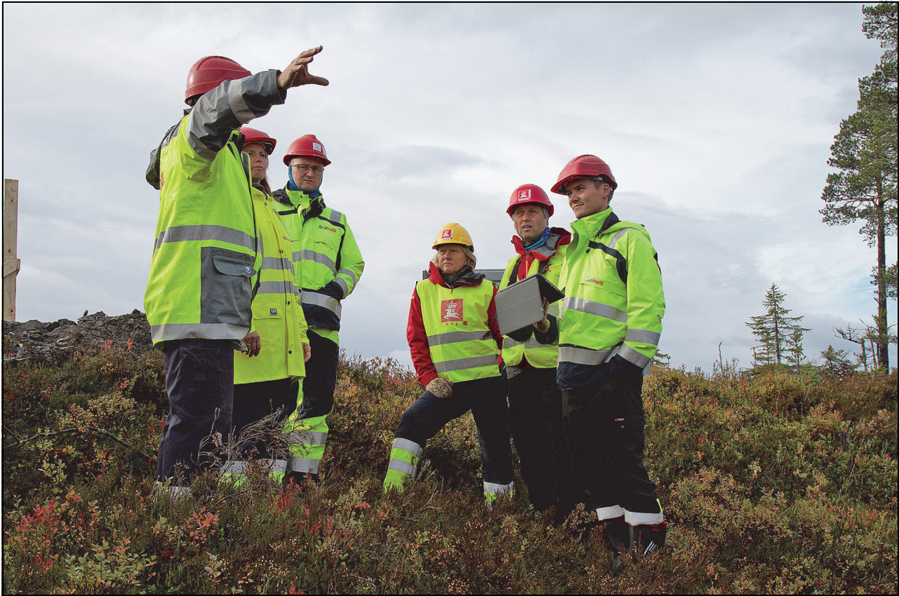
Figur 3.3 NVE på tilsyn med Statnett under byggingen av 420 kV-kraftledningen mellom Namsos og Åfjord.
