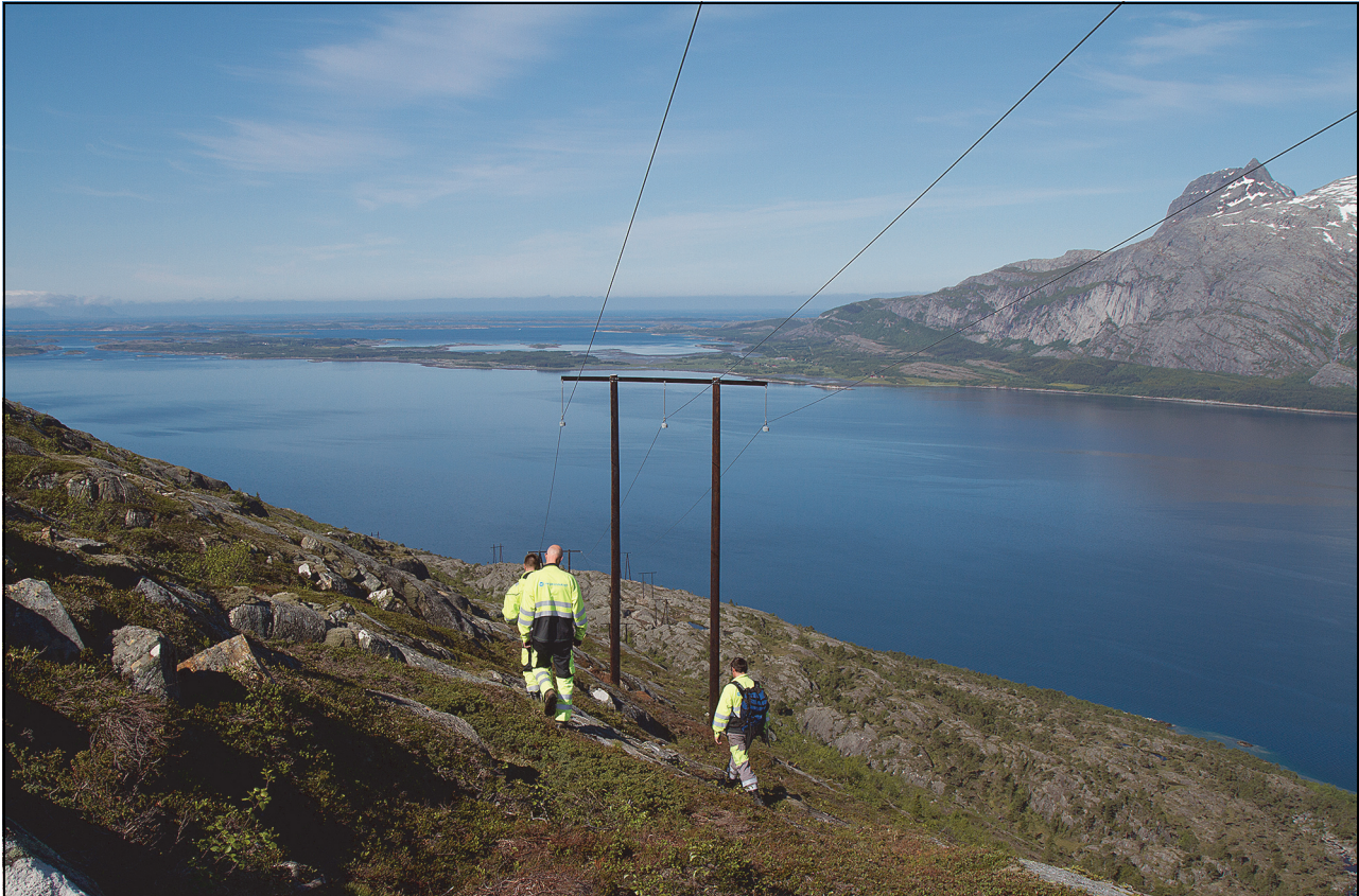
Figur 4.2 NVE på tilsyn av nybygget kraftledning/sjøkabel over Vefsnefjorden.
