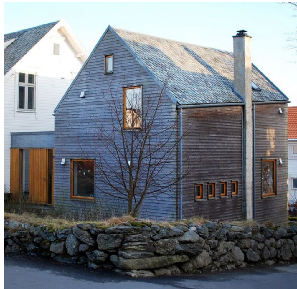
Eiganes, Stavanger. Arkitekt Brita Goldberg
