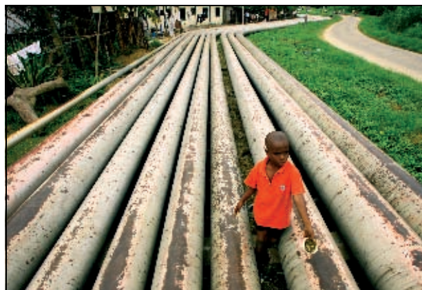
Figur 4.2 Oljerørledning gjennom en landsby i Nigeria.
