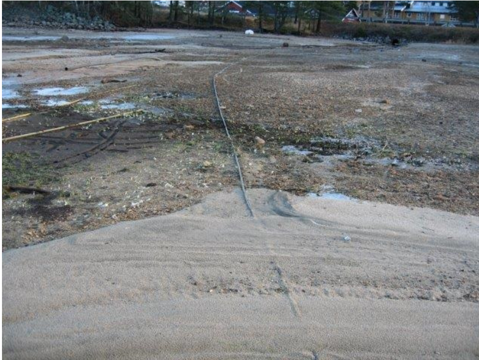
Figur 3.24 Ubeskyttet fiberkabel
