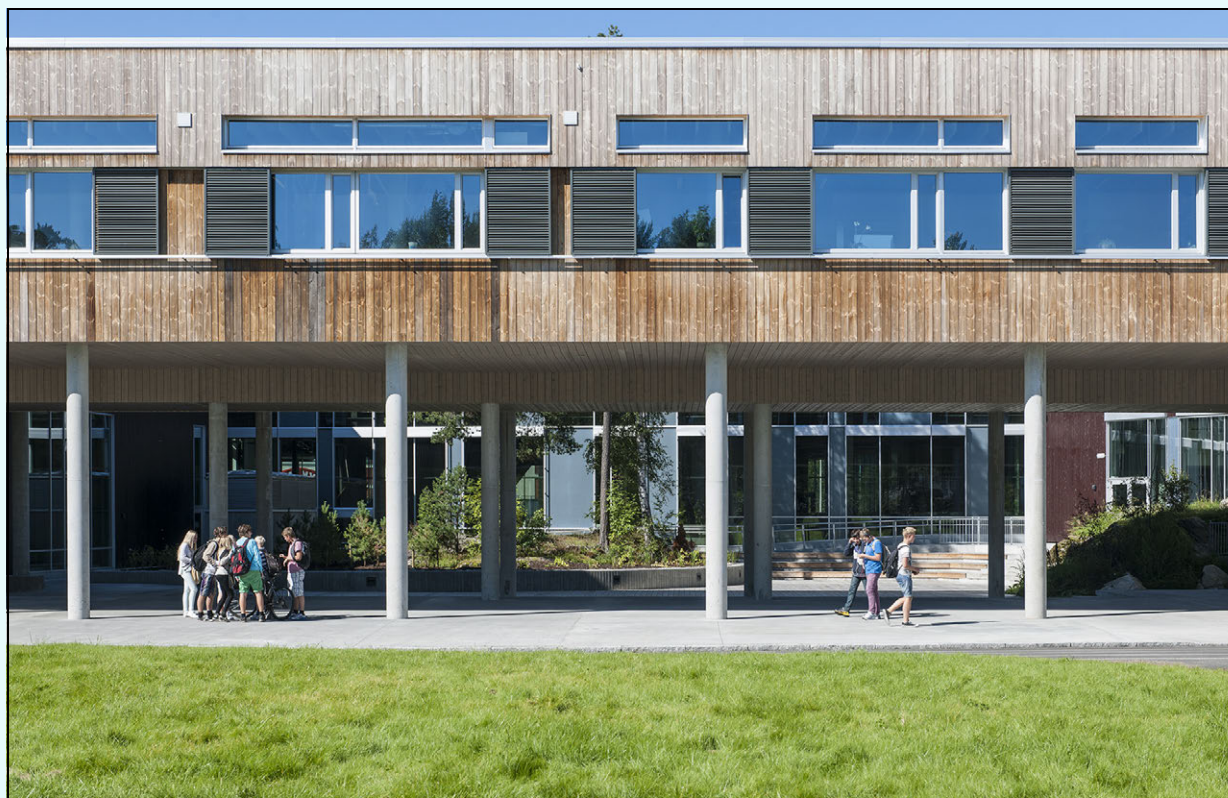
Figur 4.15 Tangenten på Nesodden er eit fleirbruksbygg med ungdomsskule, kulturskule, folkebibliotek, kommuneadministrasjon, helsestasjon og kulturlokale. Arkitekt: Ratio arkitekter.
