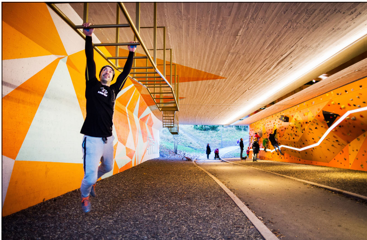
Figur 4.14 På Ammerud i Oslo er ein skummel gangtunnel oppgradert med lys, maling og treningsapparat for å betre tryggleiken. Arkitekt: Eriksen Skajaa Arkitekter og Lala Tøyen.
