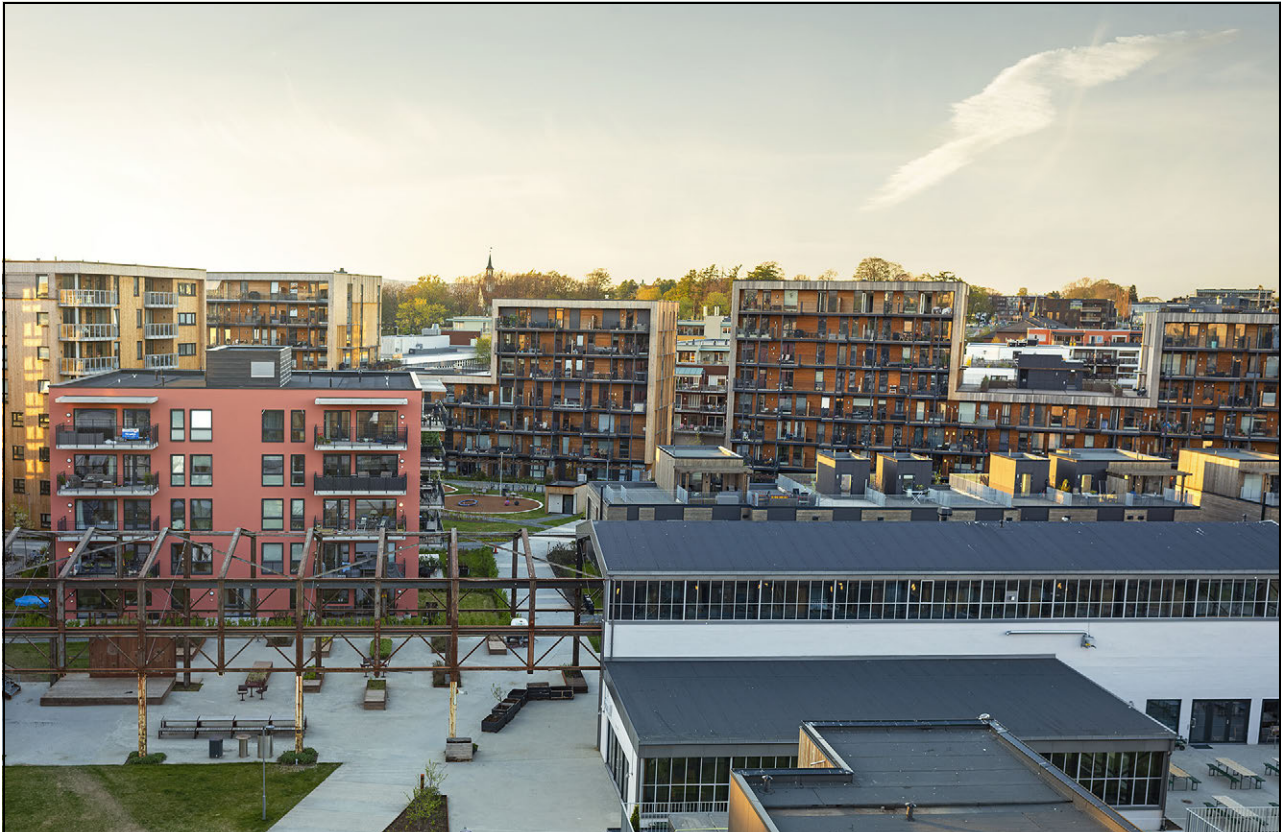
Figur 4.4 På Lilleby i Trondheim har transformasjon av eit tidlegare industriområde blitt eit variert bustadområde med variert bygningstopologi, parkar og næringsaktivitet. Arkitekt: Lund Hagem/HUS Arkitekter.
