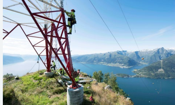
Foto: Statnett SF
