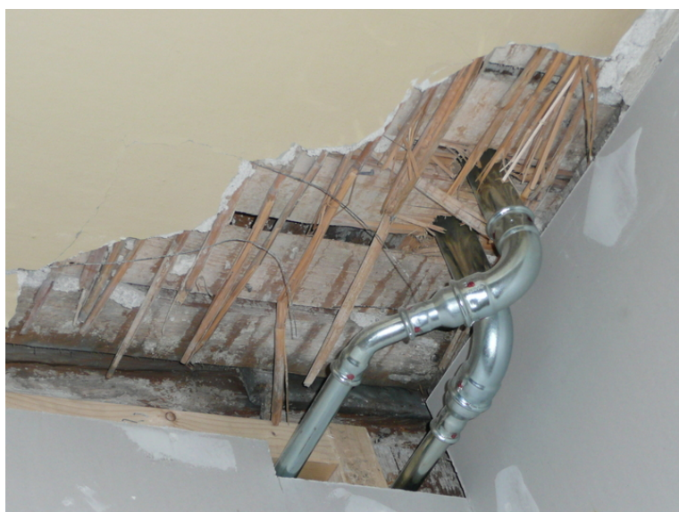
Detalj himlingen i tidligere leilighet, rabbitpuss. Opphavsrett: Statsbygg.
