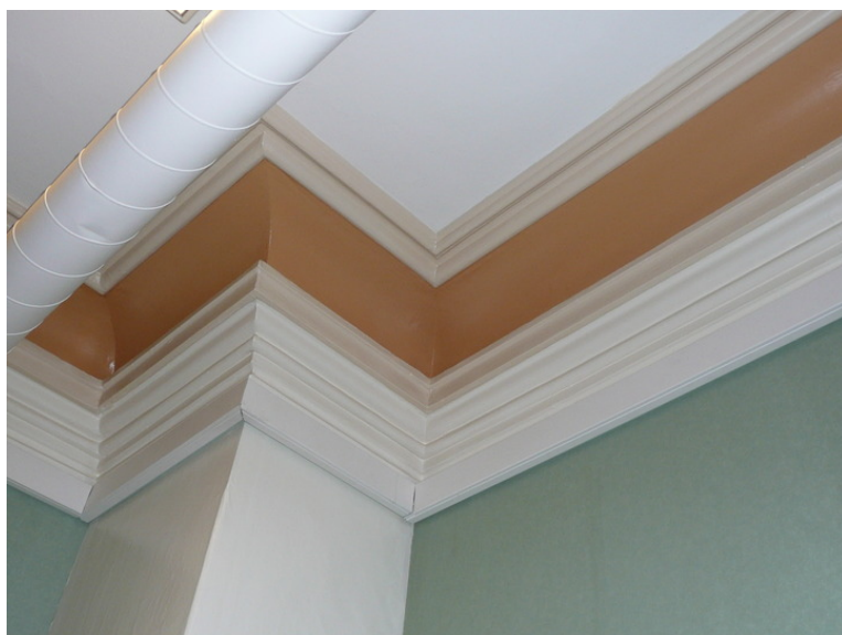
Tidligere venterom detalj taklist. Opphavsrett: Statsbygg.
