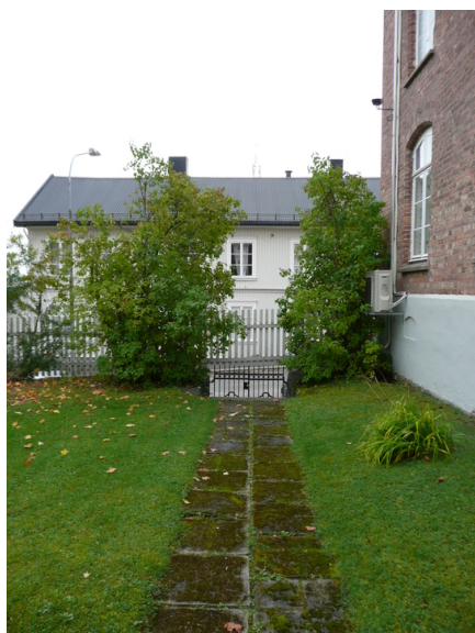
Opprinnelig vei til rettslokalets hovedinngang, sett mot vei. NB. Tregjerde bygget over opprinnelig jernportal. Opphavsrett: Statsbygg.
