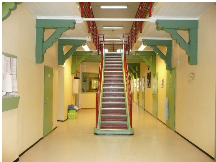
Opprinnelig trapp, galleri, bjelker og knekter i cellefløyen, 1. etg. Opphavsrett: Statsbygg.
