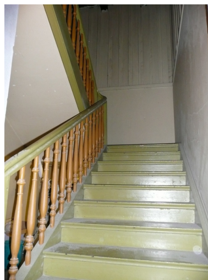
Trapp fra rettslokaler til loft. Opphavsrett: Statsbygg.
