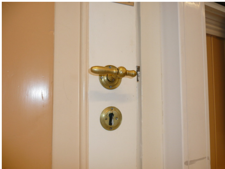
Tidligere rettsal detalj dørhåndtak. Opphavsrett: Statsbygg.
