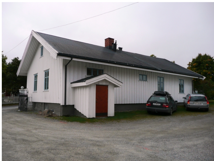
Velferdsbygg-inspektørbolig. Fasade mot nord. Opphavsrett: Statsbygg.
