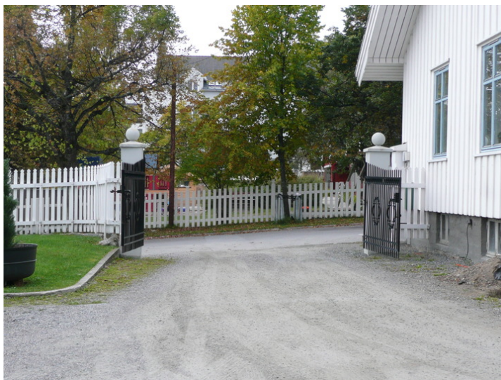
Port. NB. to portstolper til høyre ved huset. Opphavsrett: Statsbygg.
