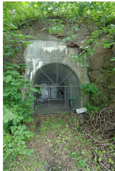
Inngang Valhalla alarmplass. Foto: Leif Anker, Forsvarsbygg
