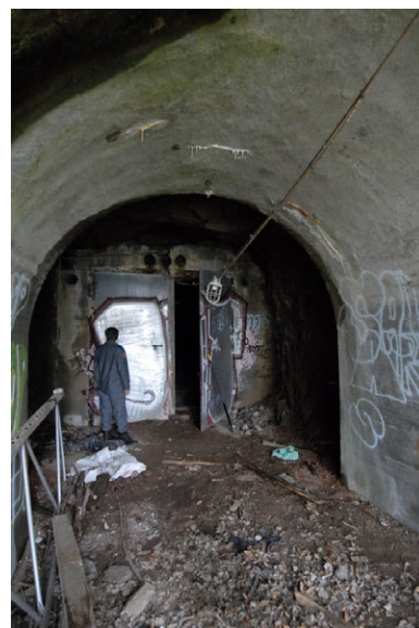
Inngang med trykkdør. Foto: Leif Anker, Forsvarsbygg
