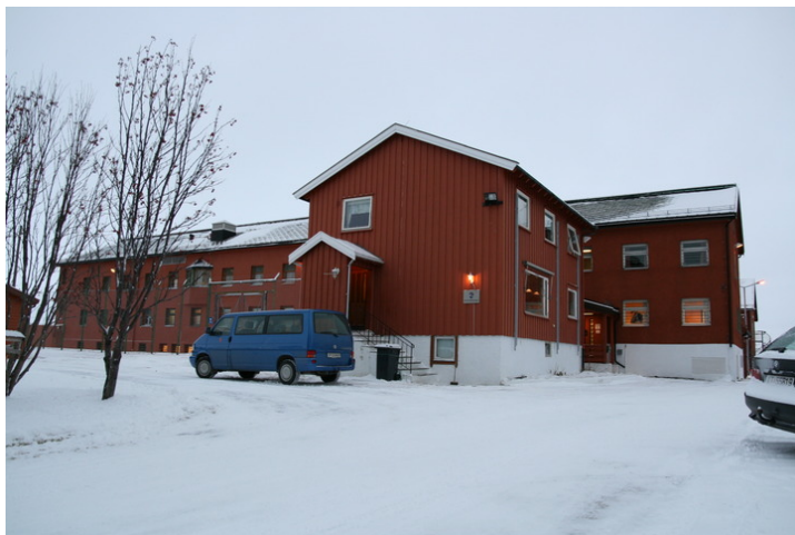
Inspektørboligen og cellebygningen fra hovedadkomsten. Opphavsrett: Statsbygg.
