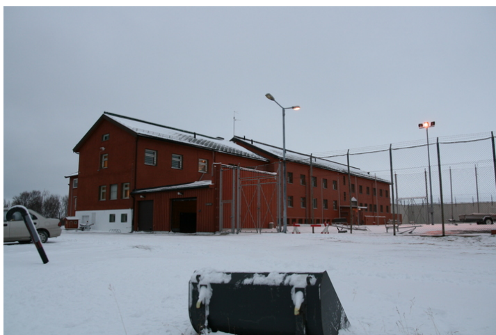
Vadsø fengsel mot luftegården. Adminstrasjonsdelen til venstre og celledelen til høyre. Bygget til i begge ender. Opphavsrett: Statsbygg.
