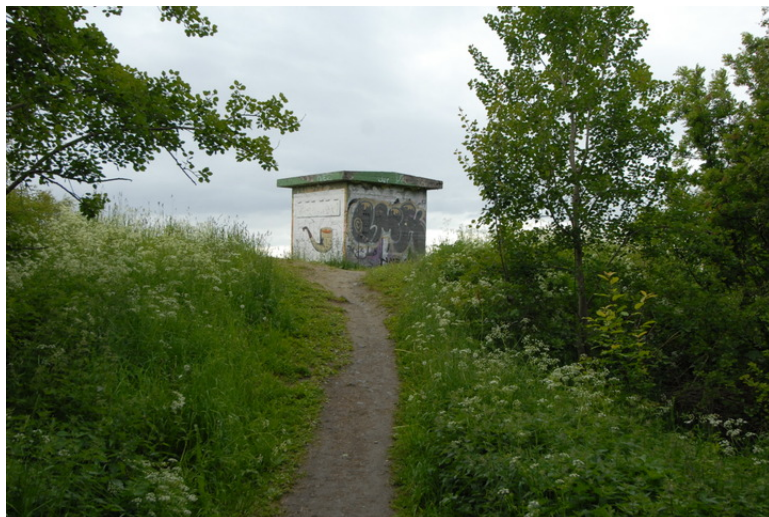
Utkikkskiosken sett fra sør(øst). Foto: Leif Anker, Forsvarsbygg.
