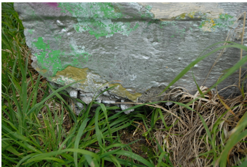
Fundament. Foto: Leif Anker, Forsvarsbygg.
