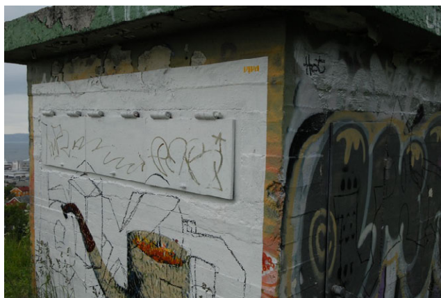
Vindusskodde i stål. Foto: Leif Anker, Forsvarsbygg.
