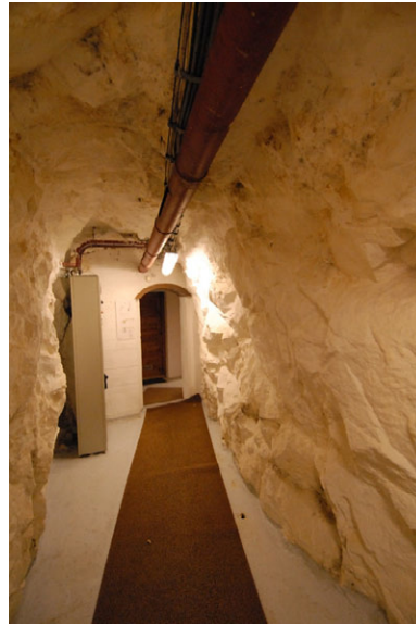
Korridor fra sluse til gang ved KO-rom. Foto: Leif Anker.
