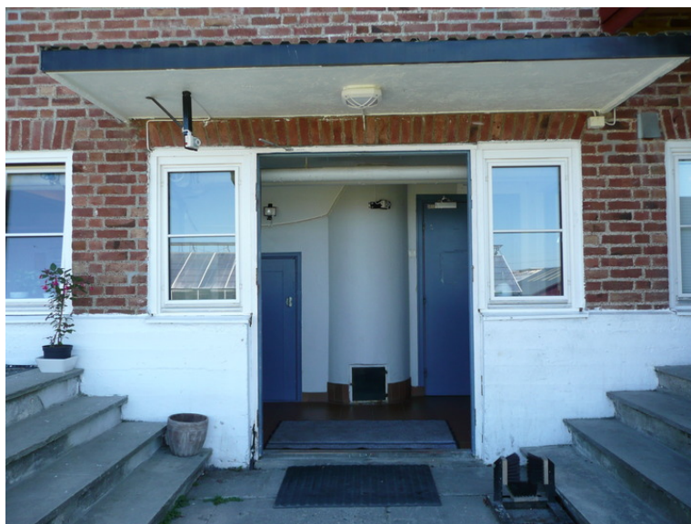
Kjellerinngang. Opphavsrett: Statsbygg.
