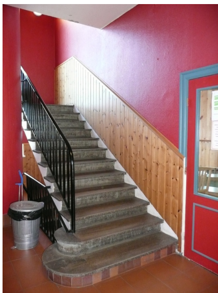
Trapp til 2. etg. Opphavsrett: Statsbygg.
