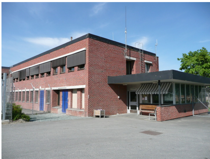
Inngang sentralvakt. Opphavsrett: Statsbygg.
