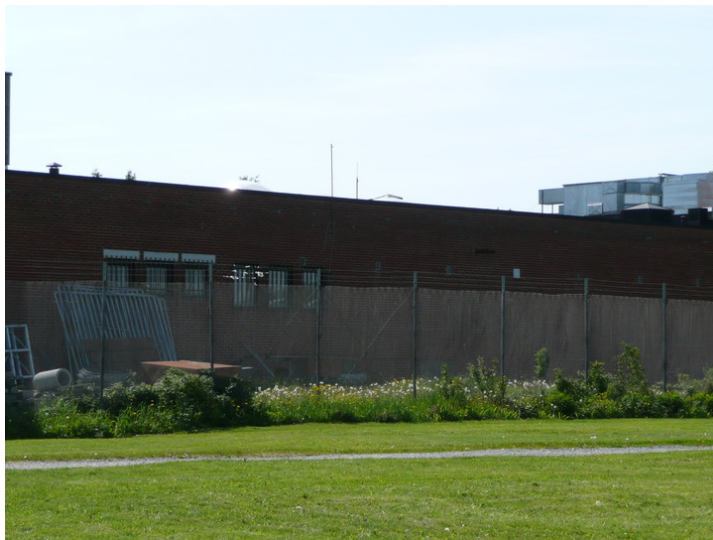
Fasade mot nordvest. Opphavsrett: Statsbygg.
