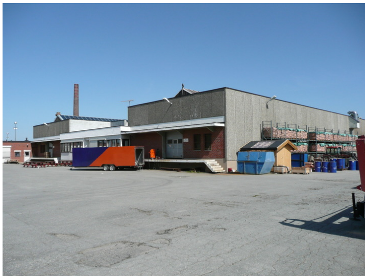
Fasade sørvest. Opphavsrett: Statsbygg.
