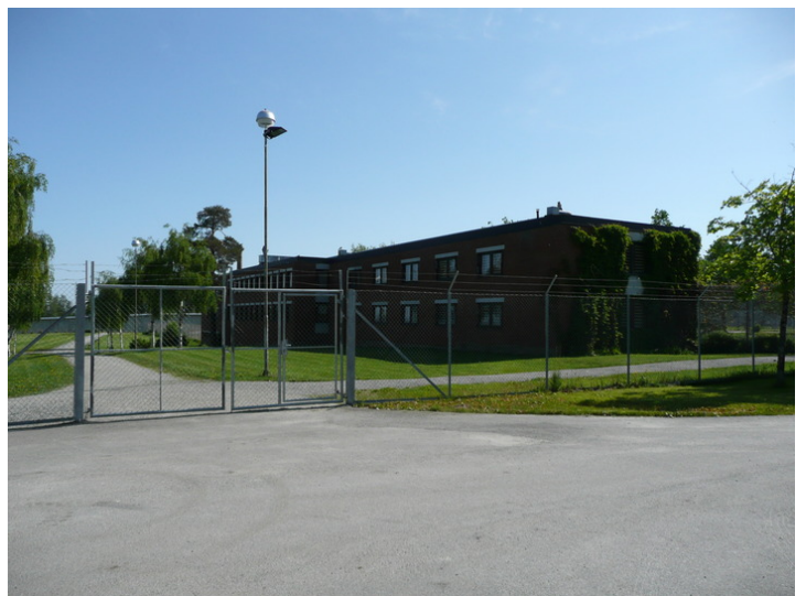
Fasade fra nordvest. Opphavsrett: Statsbygg.
