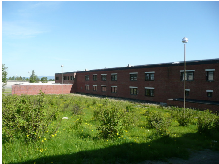
Fasade fra sydvest. Opphavsrett: Statsbygg.
