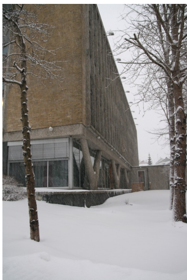
Bygningen bæres av Y-formete søyler. Opphavsrett: Statsbygg.
