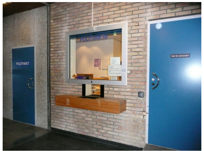
Politiets resepsjon. Opphavsrett: Statsbygg.
