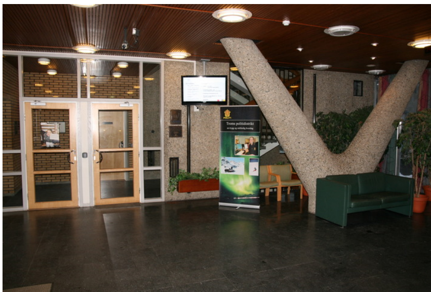
De karakteristiske y-søylene går gjennom hele bygningen. Opphavsrett: Statsbygg.
