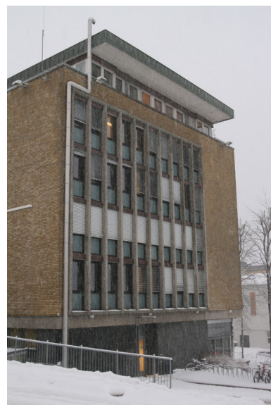
Fasaden mot sør. Opphavsrett: Statsbygg.
