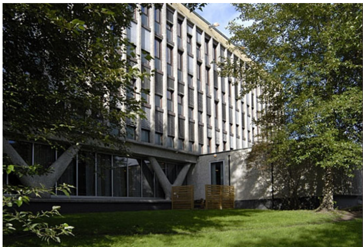
Y-formete bjelker bærer bygningen. Foto: ENTRA Opphavsrett: Entra.
