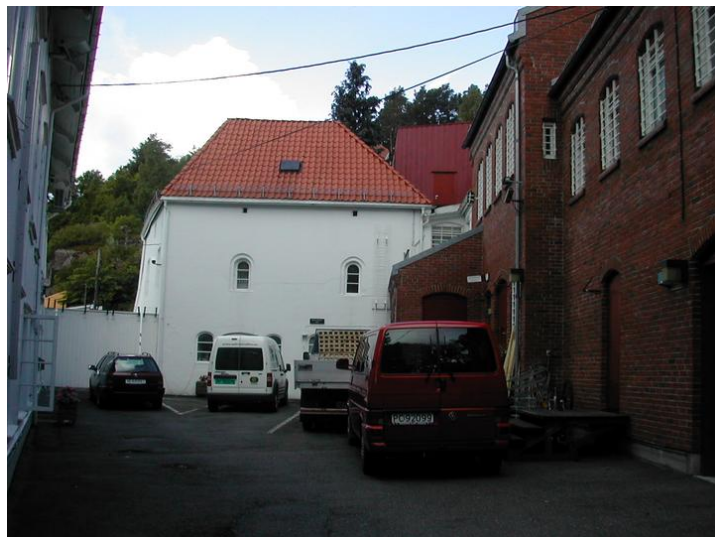
Sett fra nordøst. Opphavsrett: Kriminalomsorgen.
