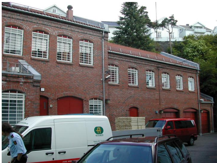
Cellebygningene fra 1984 sett fra sydøst. Opphavsrett: Kriminalomsorgen.
