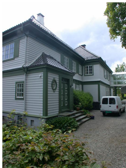
Fasade Nord. Opphavsrett: Statsbygg.
