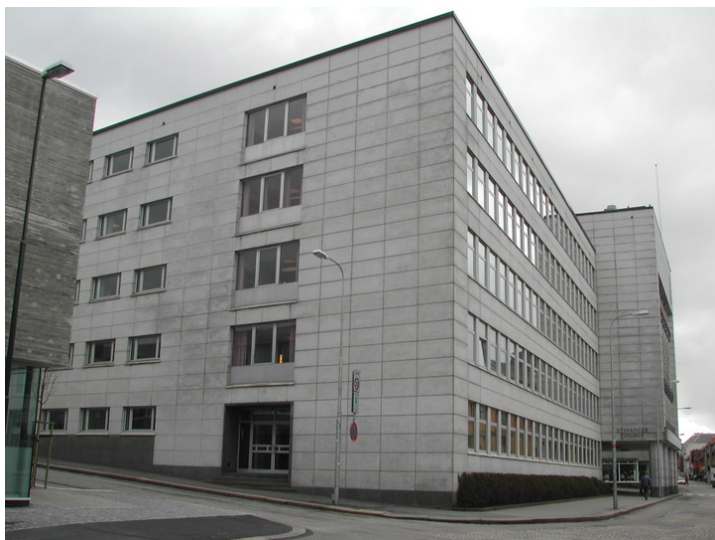
Eksteriør. Opphavsrett: Statsbygg.
