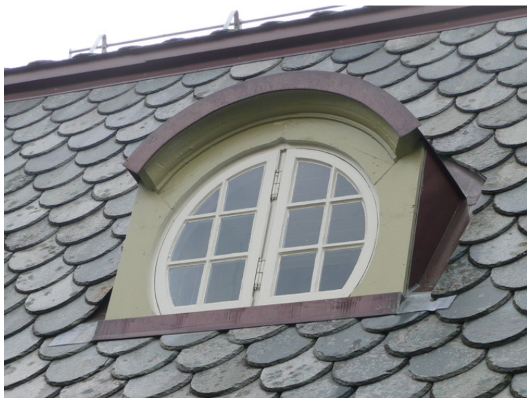
Ett gjenværende mansardvindu. Opphavsrett: Statsbygg.
