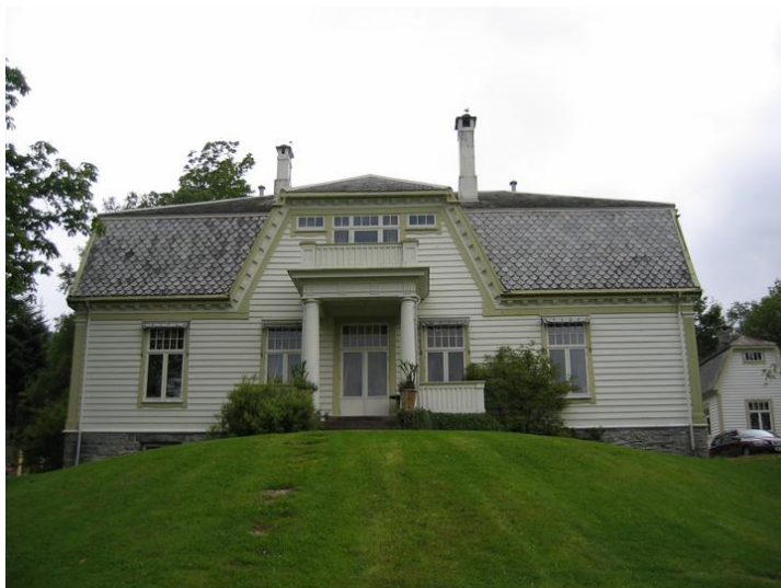
Sorenskriverkontorets fasade mot syd. Uthuset skimtes til høyre i bildet. Opphavsrett: Statsbygg.
