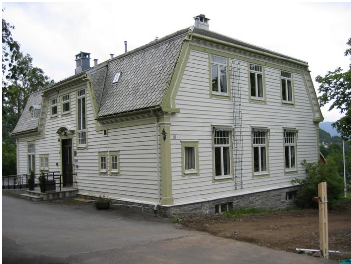
Nordre og vestre fasade. Døren til den opprinnelige kontorinngangen er erstattet med et mindre vindu. Opphavsrett: Statsbygg.
