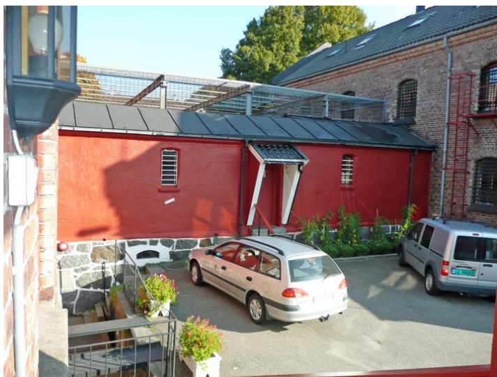
Mellomgang. Trapp ned til kjeller i forbygning til venstre. Opphavsrett: Statsbygg.
