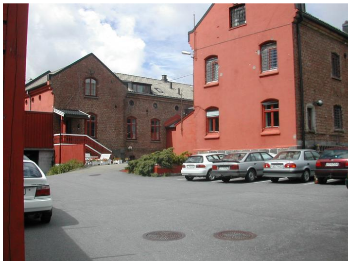
Bakgården sett fra sørøst. Forbygning til venstre, cellebygning til høyre. Foto: Terje Weber.
