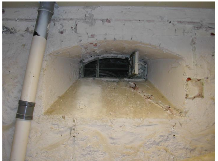
Kjellervindu. Opphavsrett: Kriminalomsorgen.
