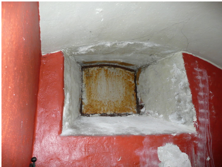
I kjelleren. Opphavsrett: Statsbygg.
