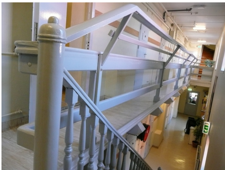
Detalj, gelender i galleri. Opphavsrett: Statsbygg.
