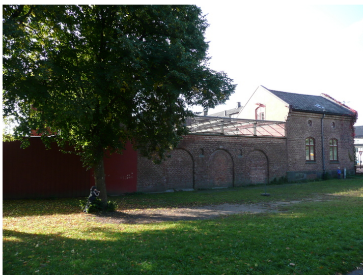
Fasade mot Herregården, mur til luftegård. Opphavsrett: Statsbygg.
