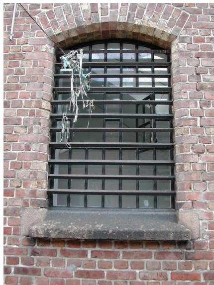
Detalj fra luftegård. Opphavsrett: Kriminalomsorgen.
