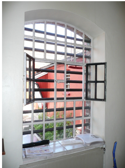
Opprinnelig vindu. I bakgrunnen mellombygg. Opphavsrett: Statsbygg.
