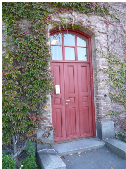
Inngangsdør. Opphavsrett: Statsbygg.
