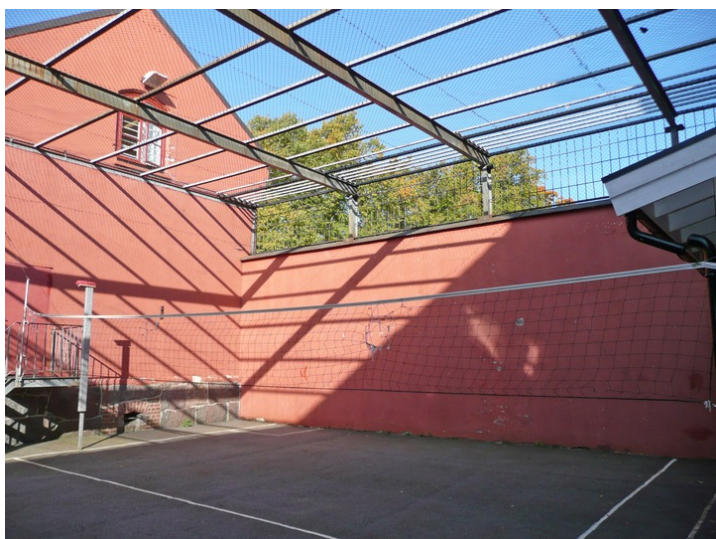
Luftgårdens mur mot nord. I bakgrunnen forbbygningen. Opphavsrett: Statsbygg.
