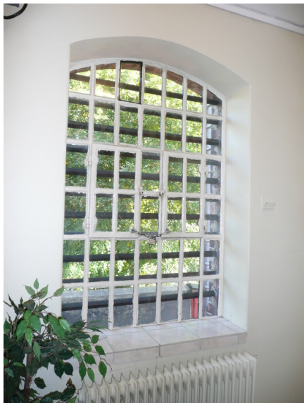
Opprinnelig vindu. Opphavsrett: Statsbygg.
