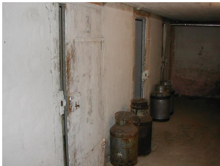
Cellegang i kjeller. Opphavsrett: Kriminalomsorgen.
