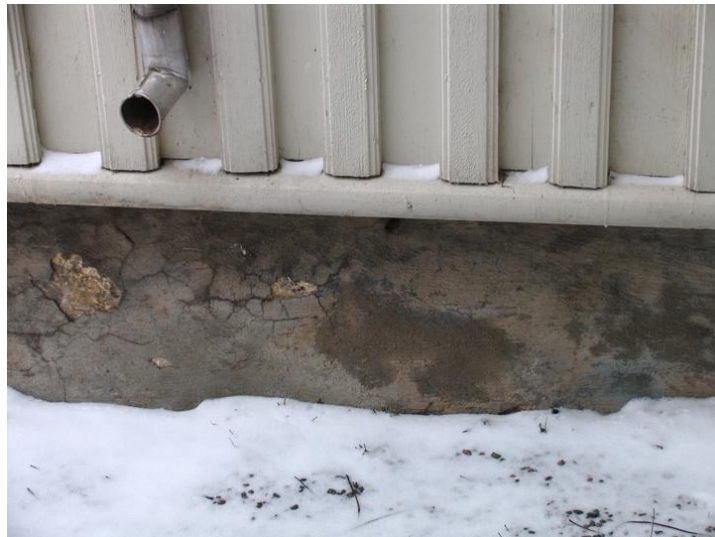
Detalj grunnmur. Opphavsrett: Kriminalomsorgen.
