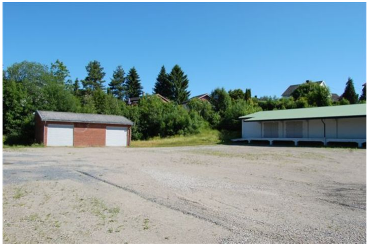
Skien sivilforsvarsmagasin og garasje. Foto: Jon H Pedersen, Sivilforsvaret.
