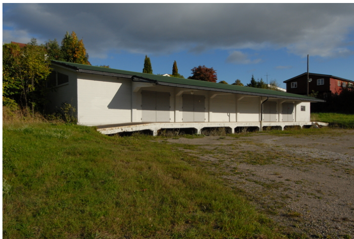
Bygg mot nordvest. Foto: Leif Anker, Forsvarsbygg.
