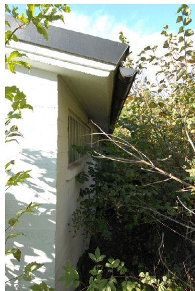
Østfasade. Foto: Leif Anker, Forsvarsbygg.
