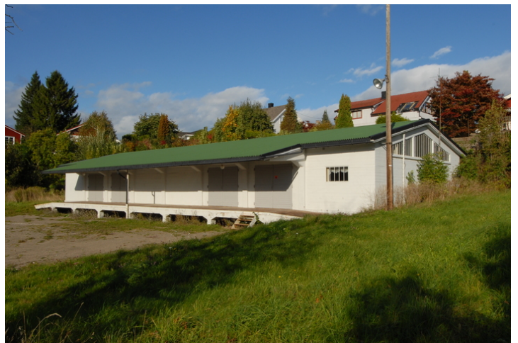
Bygg mot sørvest. Foto: Leif Anker, Forsvarsbygg.
