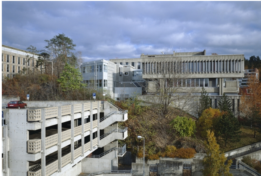
Tinghuset med gangveien i forgrunnen og politihuset bakenfor. Foto: Jiri Havran. Opphavsrett: Statsbygg.
