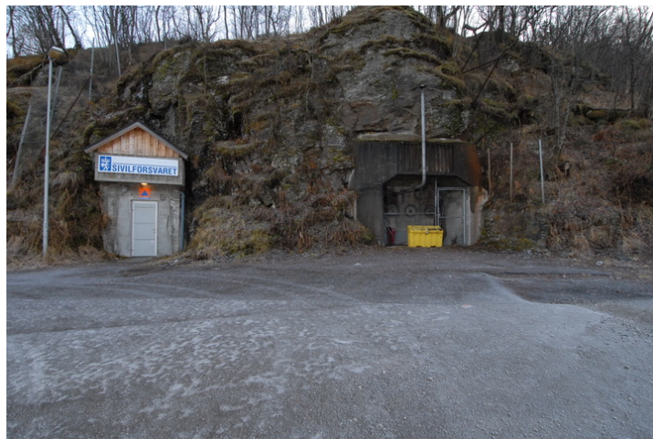
Hovedinngang og gjenmurt garasje. Foto: Leif Anker, Forsvarsbygg
