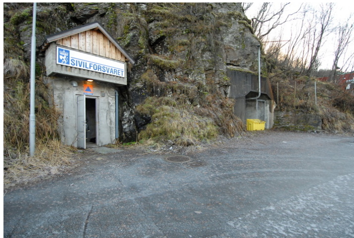
Inngangen (t.v.) og deler av ventilasjonsanlegget sett mot SV. Foto: Leif Anker, Forsvarsbygg
