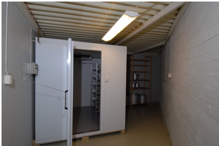
Proviantrom sett fra inngang/korridor. Foto: Leif Anker, Forsvarsbygg.
