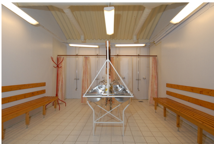
Dusjrom menn sett fra inngang/korridor. Foto: Leif Anker, Forsvarsbygg.
