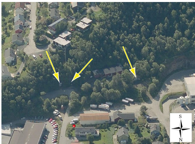
Portene til anlegget sett mot S fra lufta. Opphavsrett: Hentet fra www.gulesider.no og endret.
