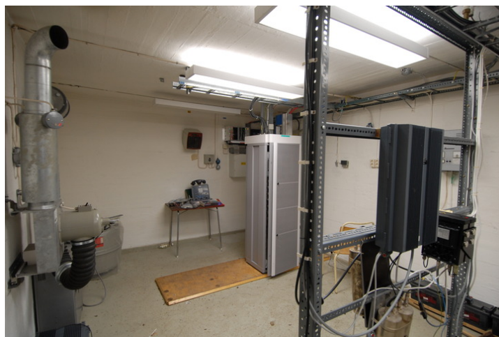
Radiorom mot øst. Foto: Leif Anker, Forsvarsbygg.
