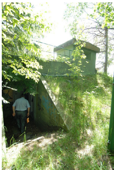
Inngang til utkikskiosk sett mot ca. sør. Foto: Leif Anker.
