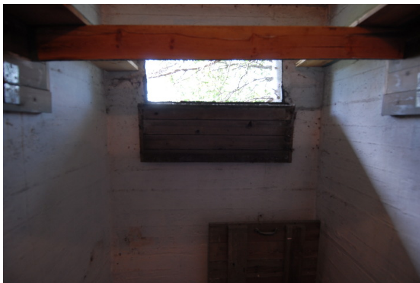
Atkomst til utkikskiosken ved radiomasta er fra bunker gjennom luke i gulvet. Foto: Leif Anker.
