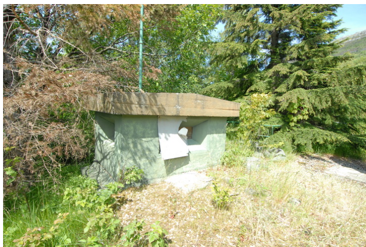
Fasade mot sør og vest. Foto: Leif Anker, Forsvarsbygg.
