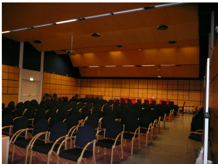
Parolesal med oppr. akustisk himling og veggplater. Avrundede hjørner. Opphavsrett: Statsbygg.
