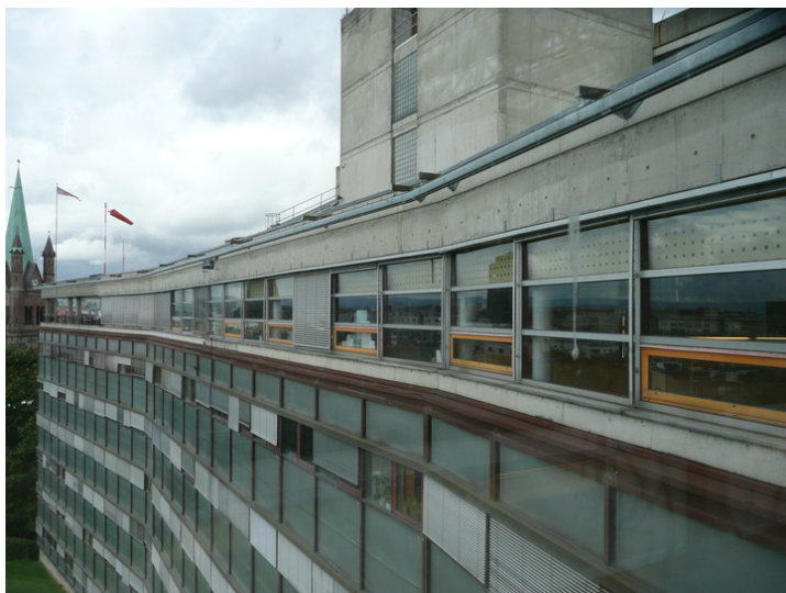
Fasade mot syd. Påbygg på adm.bygg. I bakgrunn Grønland kirke. Opphavsrett: Statsbygg.
