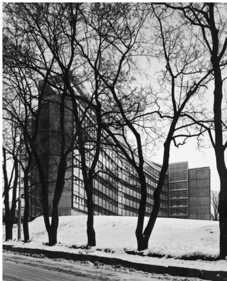
Oslo Politihus i 1979. Sett fra Borggaten. Opphavsrett: Statsbygg.
