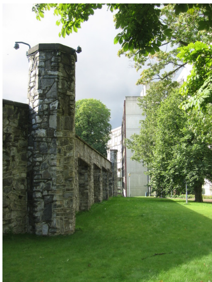
Botsfengslets ringmur sett i sammenheng med Politihuset sørøstside og parken. Registrert stor alm i midten av bildet. Opphavsrett: Statsbygg.
