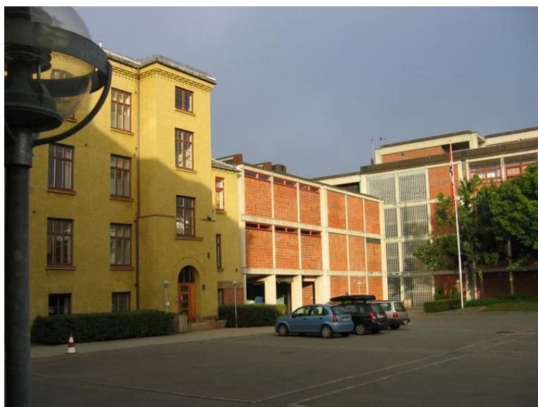
Første og andre byggetrinn sett fra gårdsplassen. Opphavsrett: Statsbygg.
