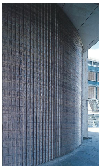
Kunstnerisk utsmykking av fasaden av Søren Ubich. Arbeidet ble gjort i forbindelse med byggetrinn 3 og nybygget som sto ferdig i 1996. Opphavsrett: Jiri Havran.
