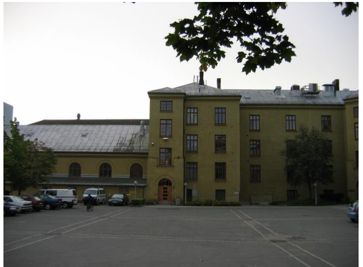
Nordvestfasade, østfløy. Opphavsrett: Statsbygg.
