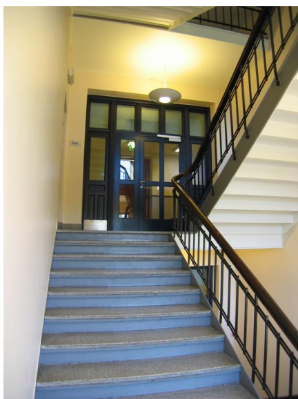
Trapperom i østfløyen. Opprinnelig trapp, senere belagt med terazzo. Opphavsrett: Statsbygg.
