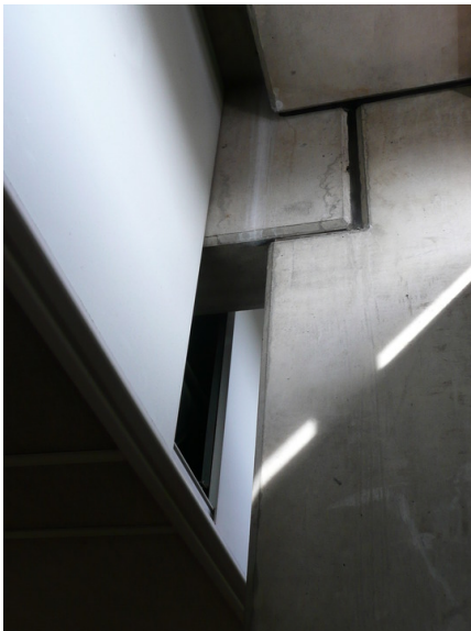
Detalj fra gangareal: Bærende elementer. Opphavsrett: Statsbygg.
