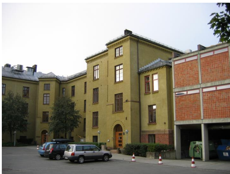
Nørøstfasade, vestfløy. Overgangen til nybygget fra 1979. Opphavsrett: Statsbygg.
