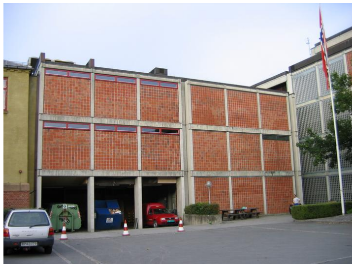
Nordøstfasade av mellombygget, sett fra den indre gårdsplassen. Opphavsrett: Statsbygg.
