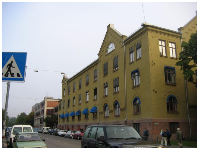
Her er den gamle gardekasernen som ble overtatt av Politiskolen i 1945 i forgrunnen og nybygget fra 1979 til venstre. Opphavsrett: Statsbygg.
