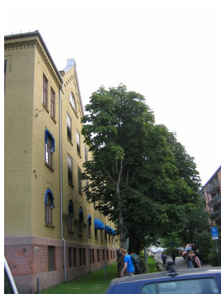
Den sørlige delen av sørøstfasaden Opphavsrett: Statsbygg.
