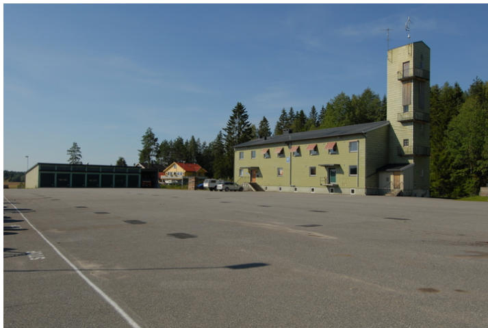
Plassen mot SV med bygg 7 garasje og bygg 5 adm. Foto: Leif Anker.
