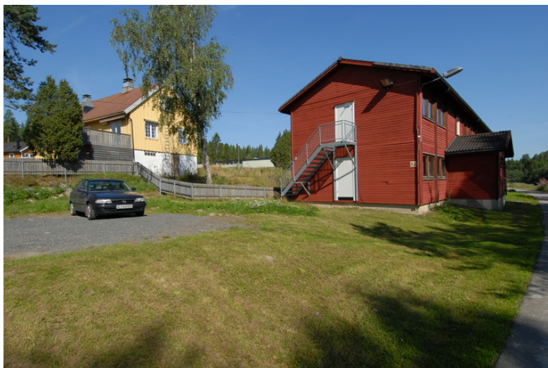
Bygg 12, satt opp til asylformål 1989 t.h., kvartermesterbolig t.v. Foto: Leif Anker.
