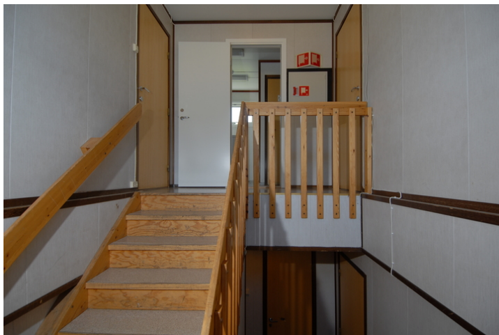
Trapperommet. Foto: Leif Anker.
