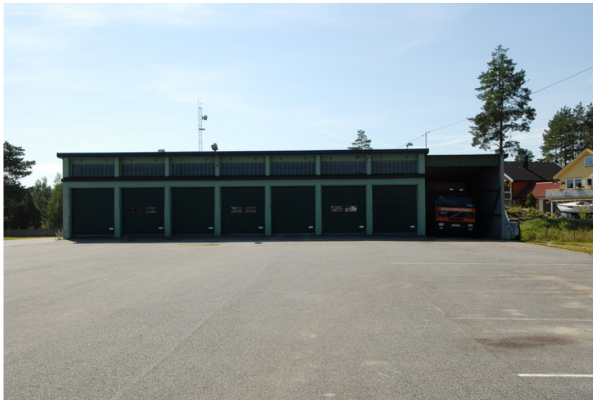
Fasade mot nord og plass. Foto: Leif Anker, Forsvarsbygg
