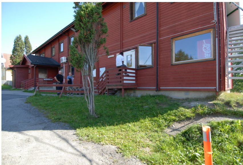
Adm.brakka sett mot NØ. Foto: Leif Anker.
