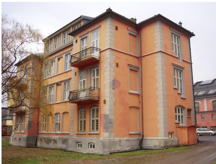
Fasade mot sør. Foto: Statsbygg Opphavsrett: Statsbygg
