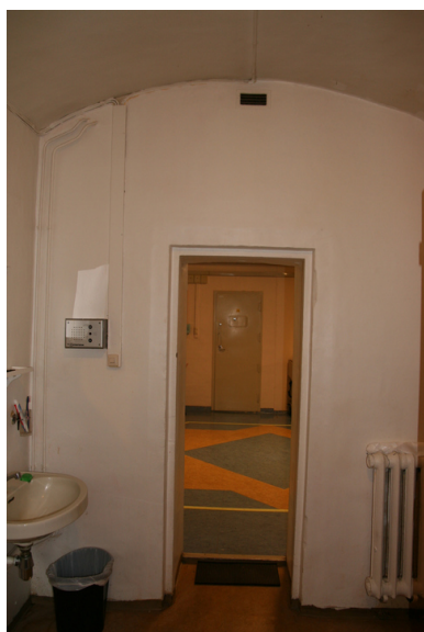
Celle mot gangen. Fengslet fikk sentralfyr og cellene radiatorer i 1912. Opphavsrett: Statsbygg.
