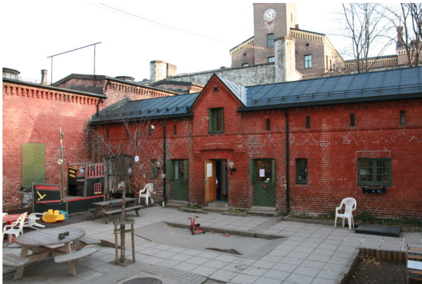
Den opprinnelige stallen bak direktørboligen er barnehage. Opphavsrett: Statsbygg.
