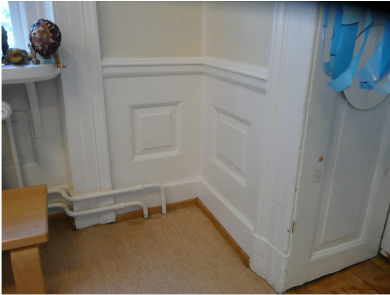
Opprinnelig brystpanel. Opphavsrett: Statsbygg.
