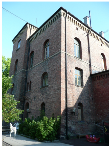
Tårnbygget sett fra direktørboligen/barnehagen. Opphavsrett: Statsbygg.
