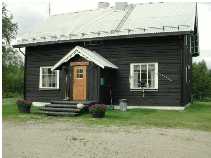
Våningshusets østfasade. Opphavsrett: Statsbygg.
