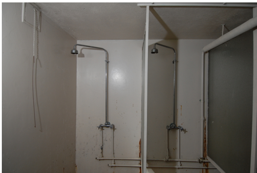
Vaskerom kjeller. Foto: Leif Anker, Forsvarsbygg.
