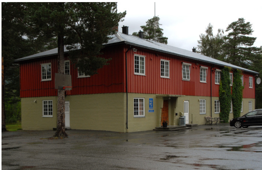
Adm.bygget sett fra sørvest. Foto: Leif Anker, Forsvarsbygg.
