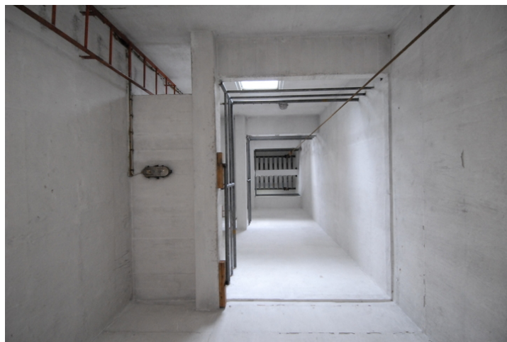
Slangetårn. Foto: Leif Anker, Forsvarsbygg.
