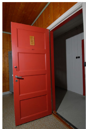
Opprinnelig dør. Foto: Leif Anker, Forsvarsbygg.
