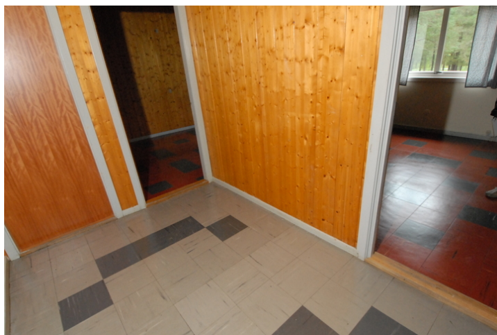
Linoleumsfliser i korridor. Foto: Leif Anker, Forsvarsbygg.
