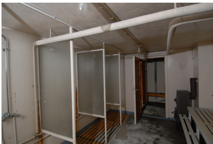
Vaskerom kjeller. Foto: Leif Anker, Forsvarsbygg.
