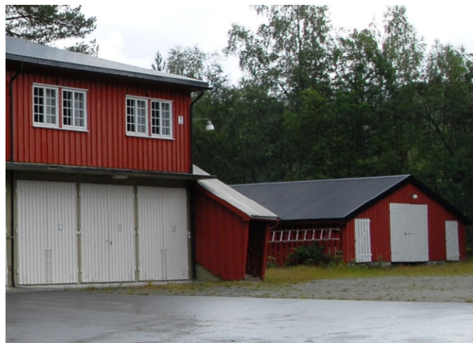
Skjulet ligger i leirens østre del, ved Brakke 3. Foto: Leif Anker.
