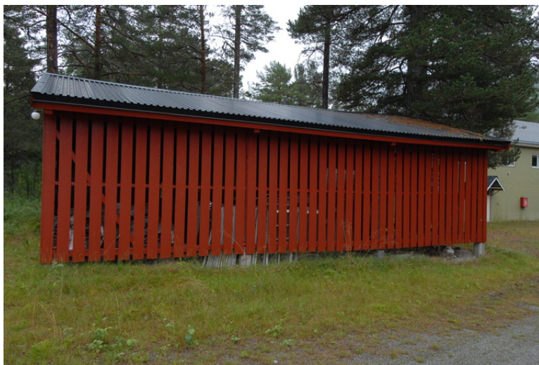
Skjulet sett fra nord. I bakgrunnen skimtes mag./u-bygget. Foto: Leif Anker, Forsvarsbygg.
