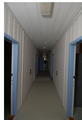
Korridor. Foto: Leif Anker, Forsvarsbygg.
