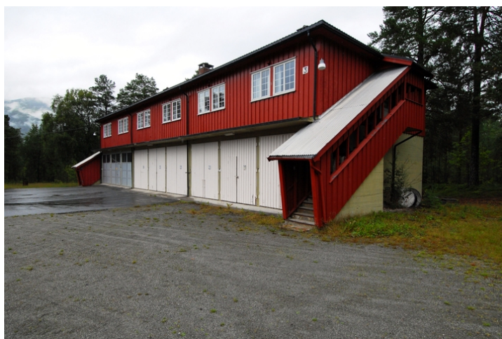
Brakke 3 sett fra sør. Foto: Leif Anker, Forsvarsbygg.
