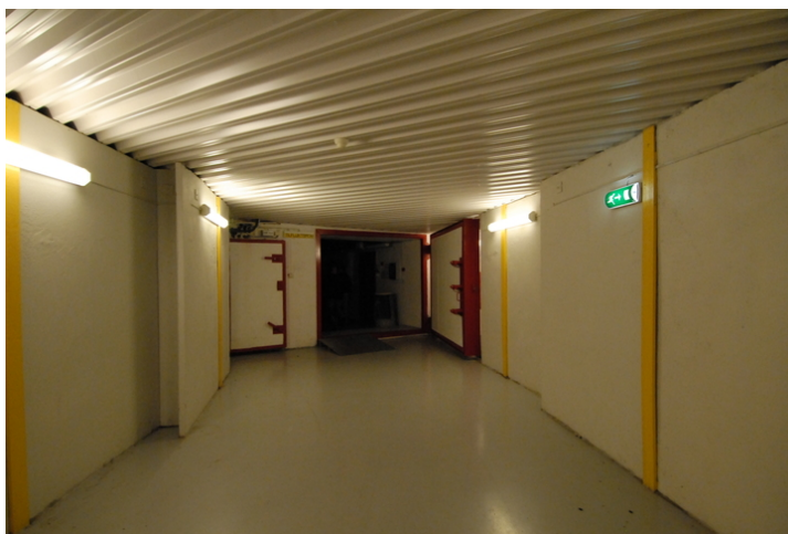
Inngangspartiet fra utgangsdør mot trykkdør og gassluse. Foto: Leif Anker.
