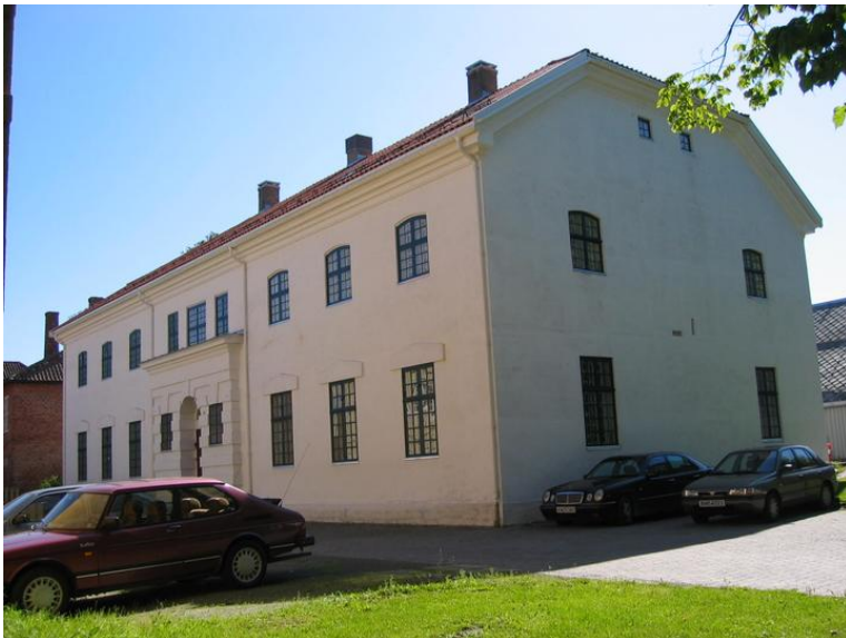
Kriminalasylet sett fra nordvest. Opphavsrett: Statsbygg.
