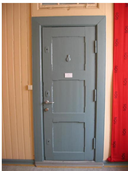
Celledør. Opphavsrett: Statsbygg.
