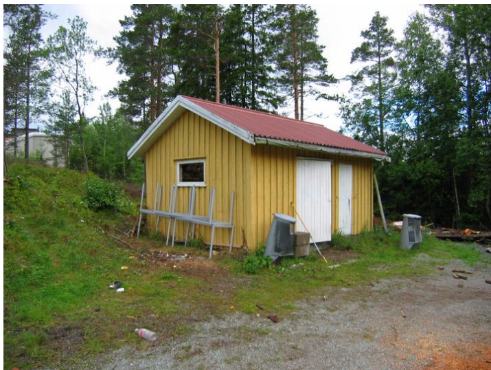
Fasader mot syd og øst. Opphavsrett: Statsbygg.
