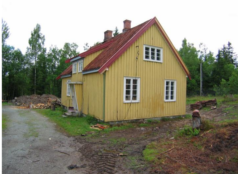
Fasade mot syd og vest Opphavsrett: Statsbygg.
