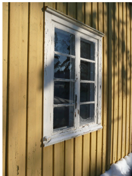
Vinduene er opprinnelige. Opphavsrett: Statsbygg.
