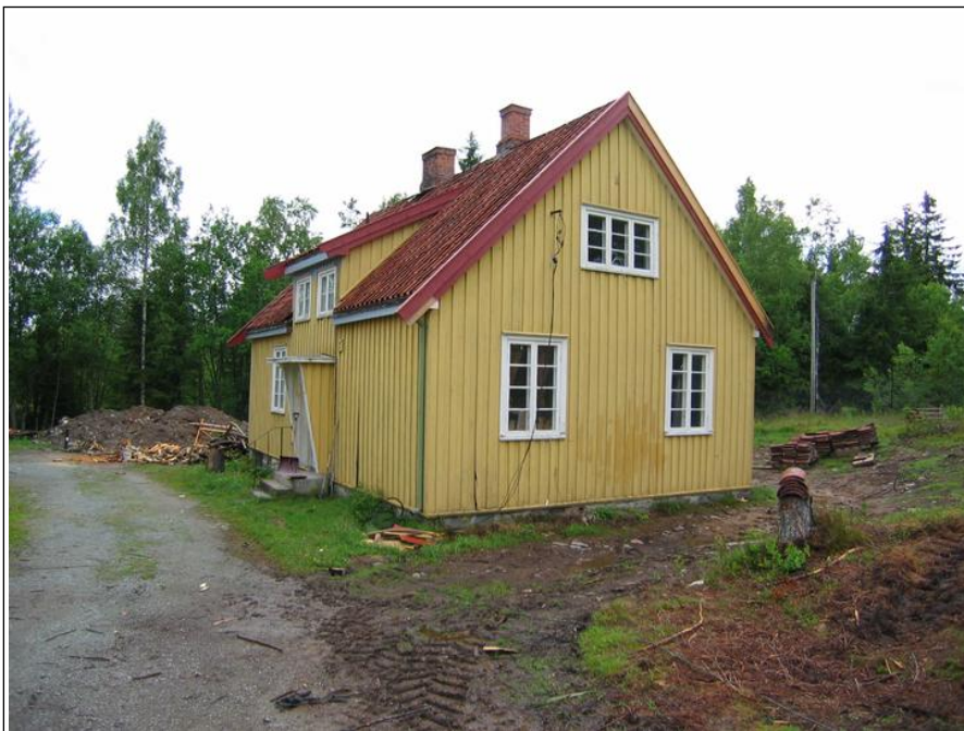
Fasade mot syd og vest Opphavsrett: Statsbygg.
