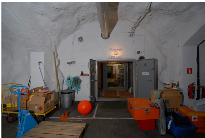
Gassluse fra garasje. Foto: Leif Anker, Forsvarsbygg
