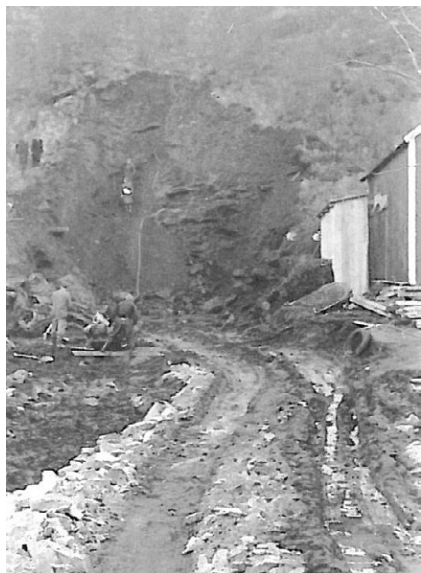
Fra anleggsarbeidene i 1958. Opphavsrett: Nordland SFD.
