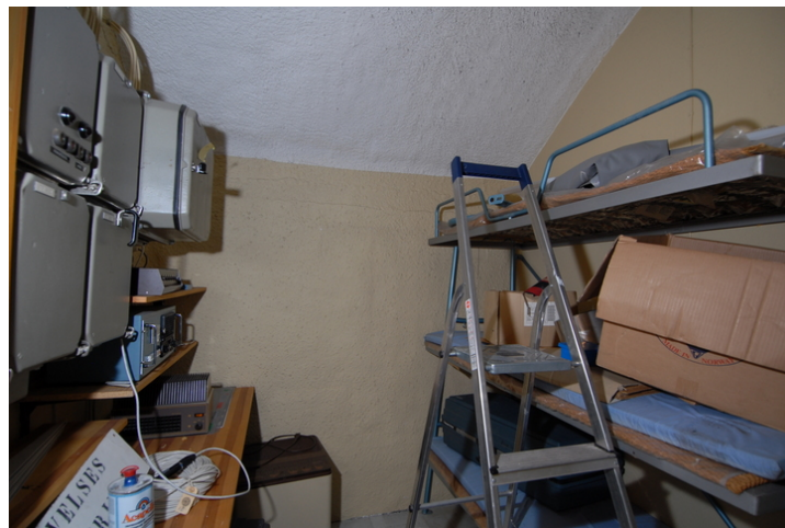
Radio/forlegningsrom. Foto: Leif Anker, Forsvarsbygg
