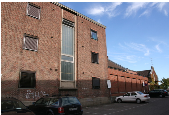
Fasade mot sør med gjennomgående vindu i hovedtrappeløpet. Til høyre i bildet sees Horten fengsel. Opphavsrett: Statsbygg.
