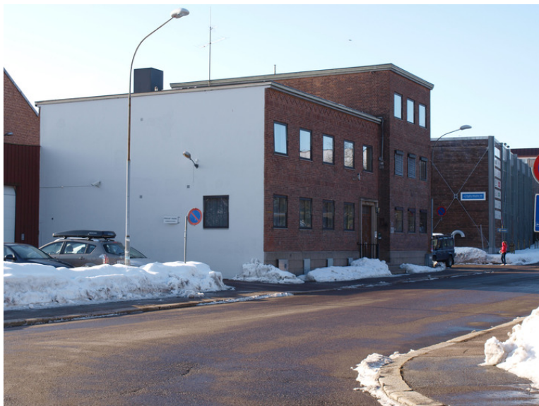
Nordveggen i pusset mur viser hvor bygningen opprinnelig skulle forlenges. Statsbygg.
