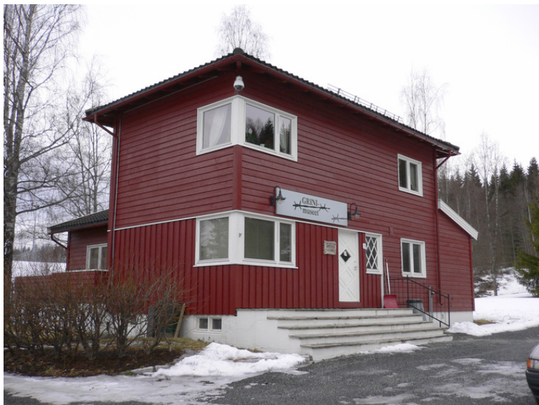
Fasade mot øst. Opphavsrett: Statsbygg.
