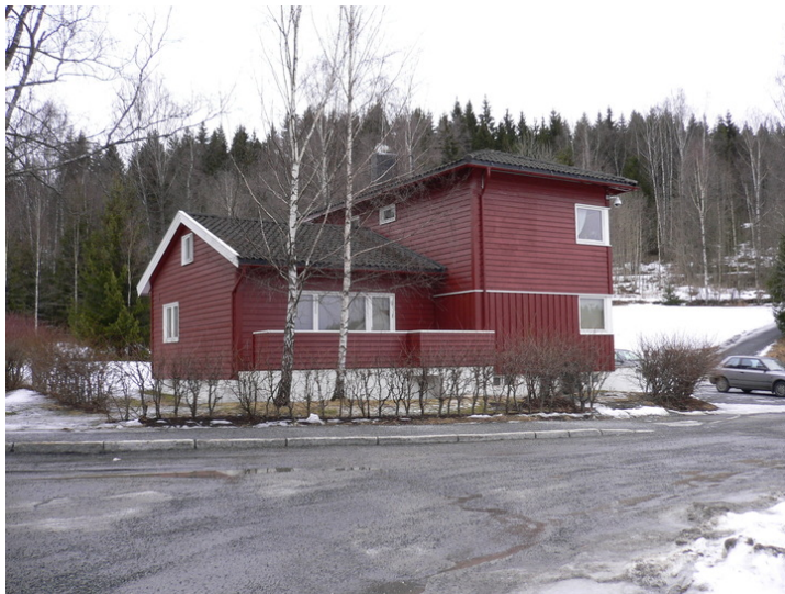
Fasade mot sør Foto: Statsbygg Opphavsrett: Statsbygg.
