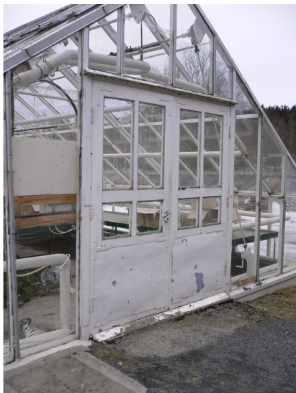
Detalj fra drivthus lengst mot vest Opphavsrett: Statsbygg.
