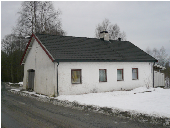
Fasade mot nordvest. Opphavsrett: Statsbygg.
