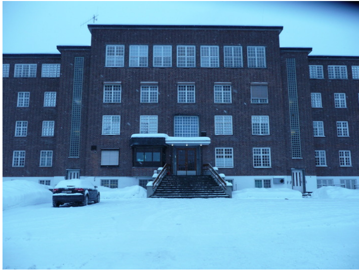
Inngangsparti. Opphavsrett: Statsbygg.
