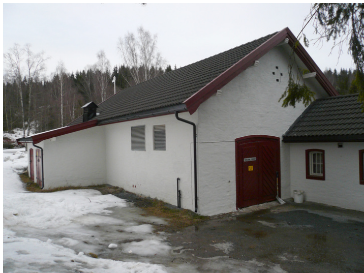
Kraftstasjonens fasade mot sørvest. Hybelen til høyre. Opphavsrett: Statsbygg.
