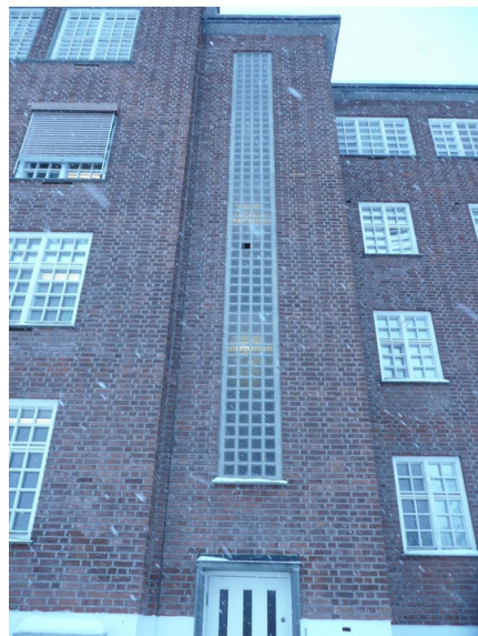
En rute i trapperommets vindu ble fjernet under krigen, angivelig et skyteskår. Opphavsrett: Statsbygg.
