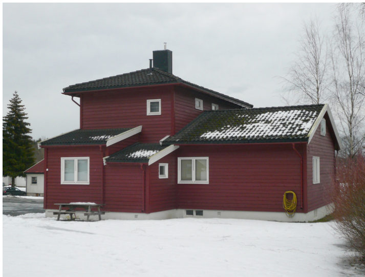
Fasade mot nord. Opphavsrett: Statsbygg.
