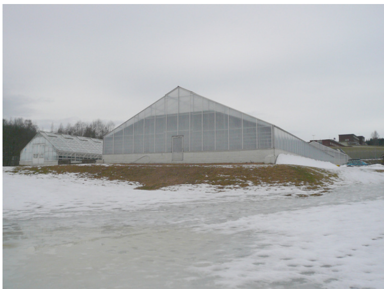
Drivhus. Fasader mot sør Opphavsrett: Statsbygg.
