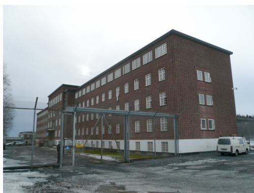
Nordfasade Opphavsrett: Statsbygg.
