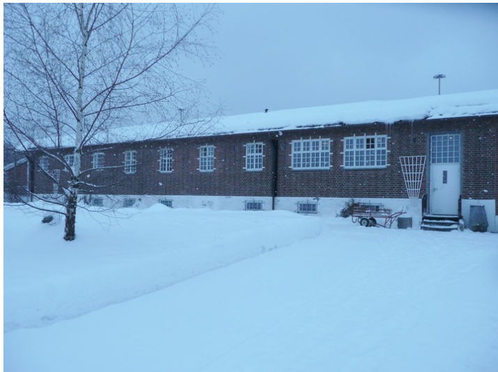
Den opprinnelige delen av bygningen. Opphavsrett: Statbygg.
