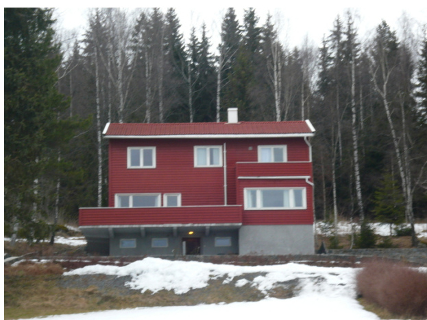
Direktørboligen. Opphavsrett: Statsbygg.
