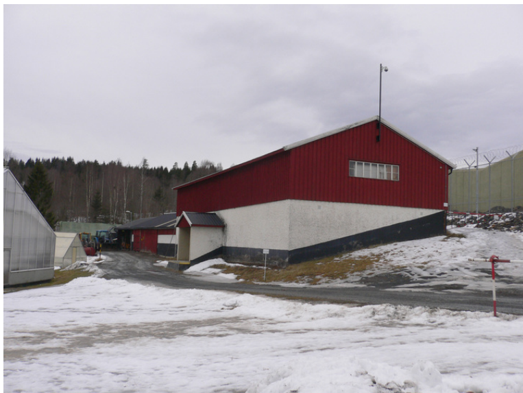
Fasade mot øst. Inngang til potetkjellene midt på låvebygningen. Foto: Statsbygg Opphavsrett: Statsbygg.
