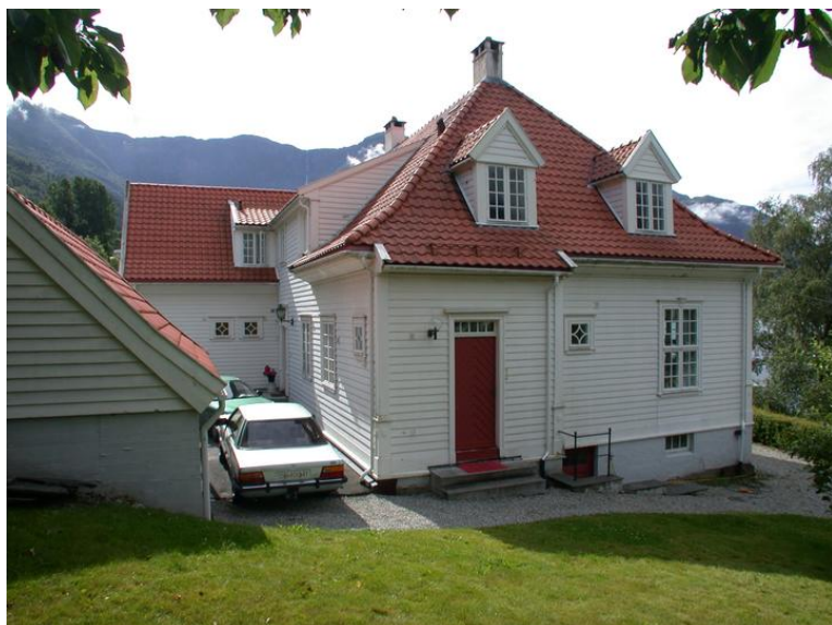
Fasade mot nordvest. Kjøkkeninngangen. Opphavsrett: Statsbygg.
