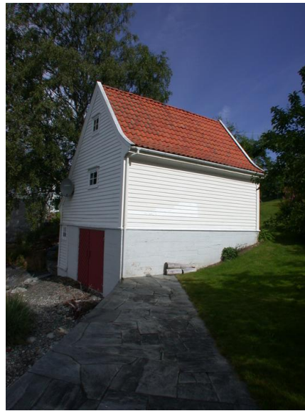
Fasade sørøst. Opphavsrett: Statsbygg.
