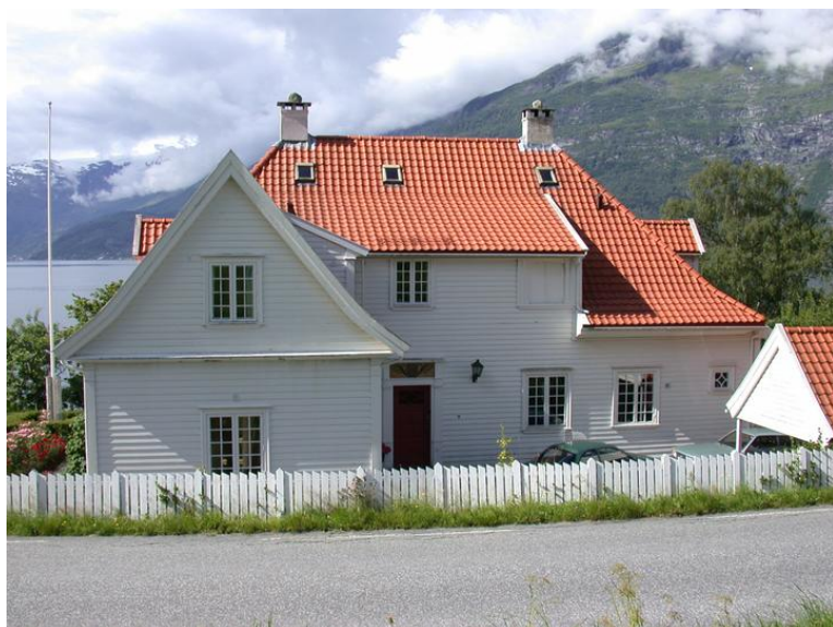
Fasade mot nordøst, veien. Inngang til boligen. Opphavsrett: Statsbygg.
