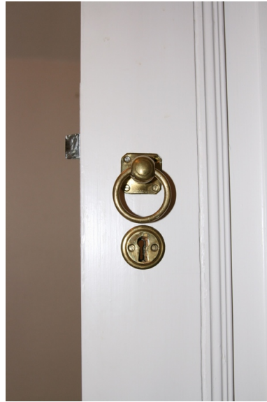
Skapdør soverom. Opphavsrett: Statsbygg.
