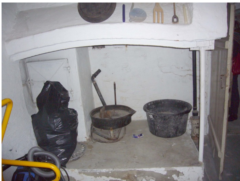
Grue i kjeller under kjøkken i forbygningen. Opphavsrett: Statsbygg.
