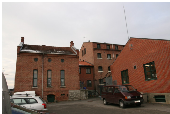
Forbygningens østfasade, med mellombygning, cellebygning og verksted til høyre. Opphavsrett: Statsbygg.
