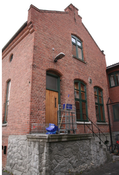
Fasade mot nord. Inngang fra bakgård. Opphavsrett: Statsbygg.
