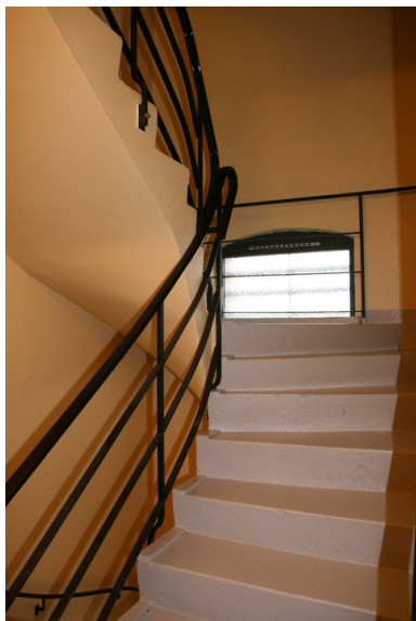
Nyere trapp i cellefløyens sørøstre hjørne for adkomst til verkstedbygningen. Opphavsrett: Statsbygg.
