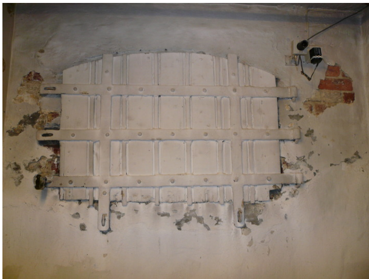
Låsbar kjellerluke i cellefløyen. Opphavsrett: Statsbygg.
