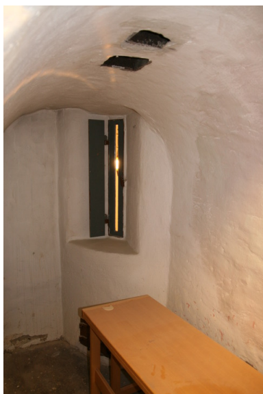
Nisje og gulvluke inn til isolat i kjeller. Opphavsrett: Statsbygg.
