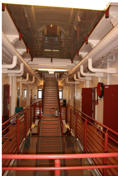
Cellegang, 2. etasje. Opphavsrett: Statsbygg.
