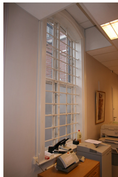
Opprinnelig vindu forbygningen ut mot luftegården. Opphavsrett: Statsbygg.
