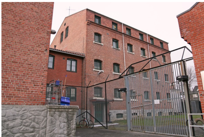
Cellebygningens østfasade. Forbygning til venstre, mellombygg i midten. Opphavsrett: Statsbygg.
