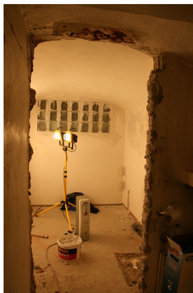
Isolat i kjeller under oppussing (2008). Opphavsrett: Statsbygg.
