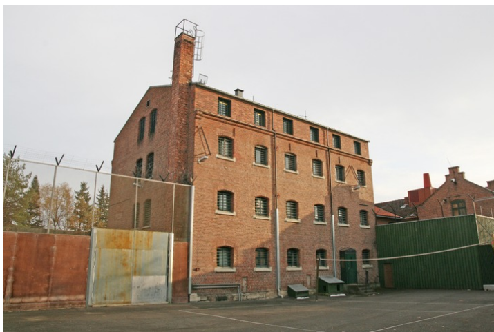
Cellebygningens vestfasade. I bakgrunnen forbygningen. Opphavsrett: Statsbygg.
